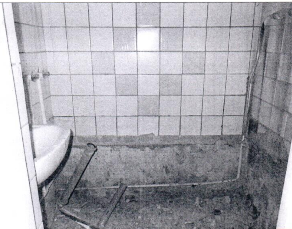
Описание: Вид внутри Объекта
