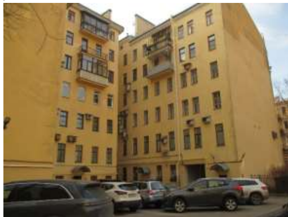
Фото 2. Вид здания, в котором расположен Объект оценки
