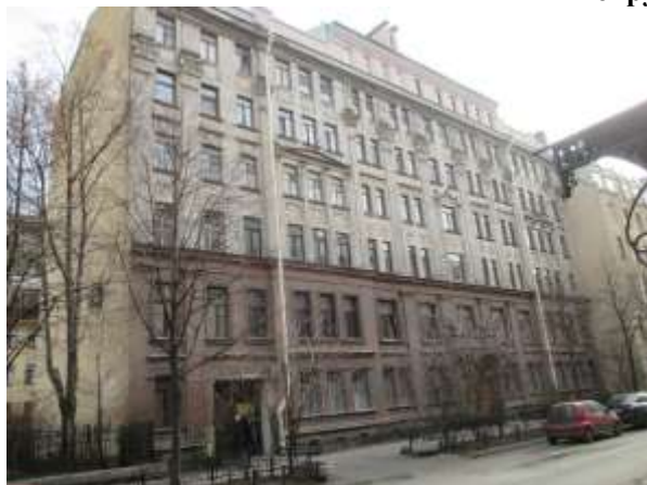
Фото 1. Вид здания, в котором расположен Объект оценки
