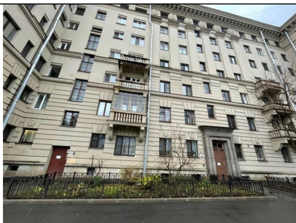
Фото 12. Вид здания расположения Объекта оценки
