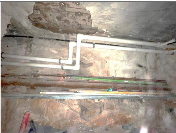
Фото 23. Типичное состояние Объекта оценки
