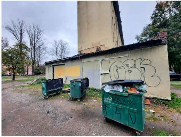
Фото № 9. Внешний вид здания
