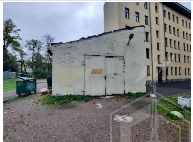
Фото № 8. Внешний вид здания
