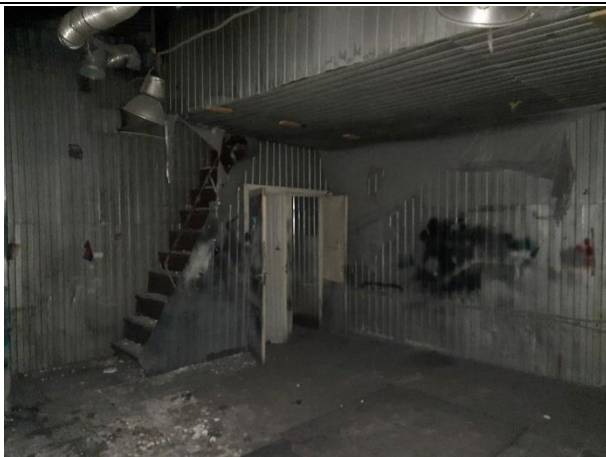
Фото № 15. Внутреннее состояние здания
