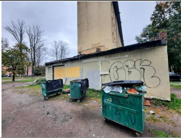
Фото № 9. Внешний вид здания
