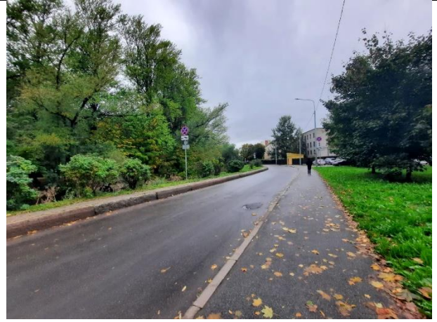
Фото № 2. Подъездные пути
