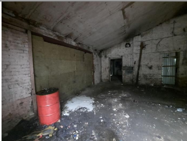
Фото № 13. Внутреннее состояние здания
