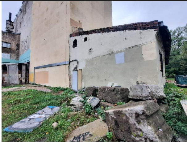
Фото № 11. Внешний вид здания
