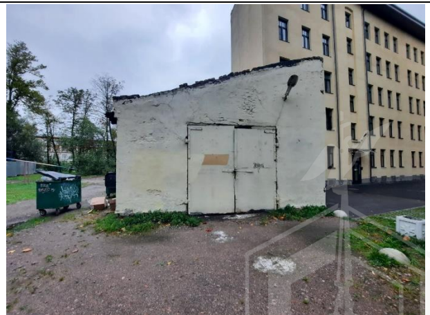
Фото № 8. Внешний вид здания
