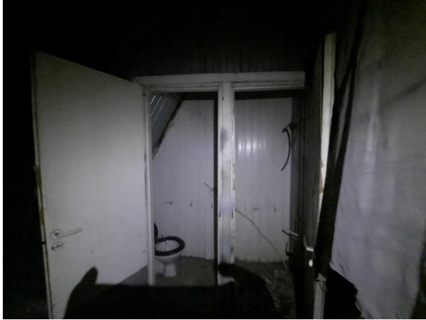
Фото № 19. Внутреннее состояние здания
