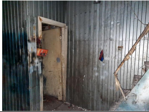
Фото № 17. Внутреннее состояние здания
