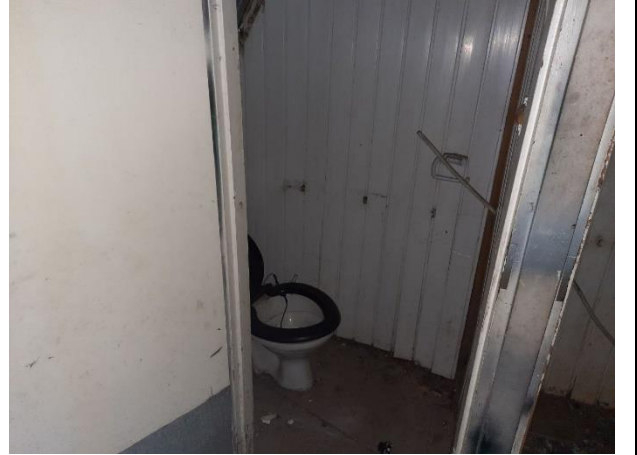
Фото № 20. Внутреннее состояние здания
