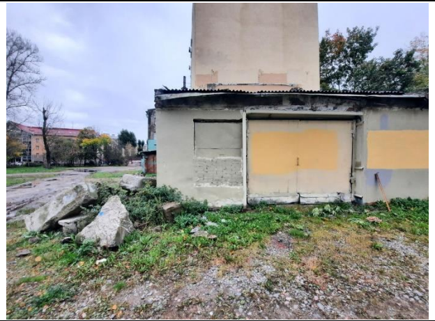
Фото № 10. Внешний вид здания
