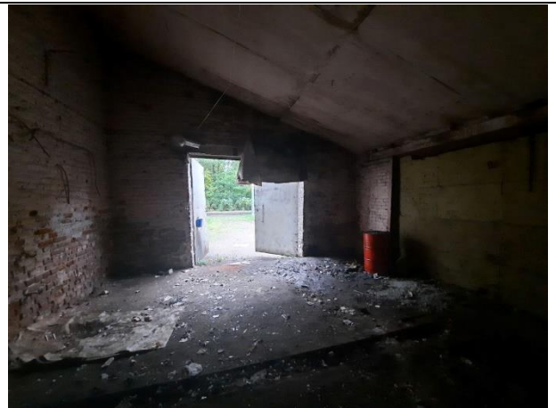
Фото № 14. Внутреннее состояние здания
