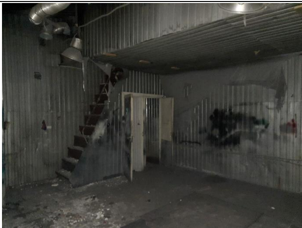
Фото № 15. Внутреннее состояние здания
