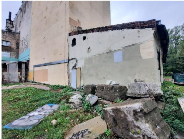
Фото № 11. Внешний вид здания
