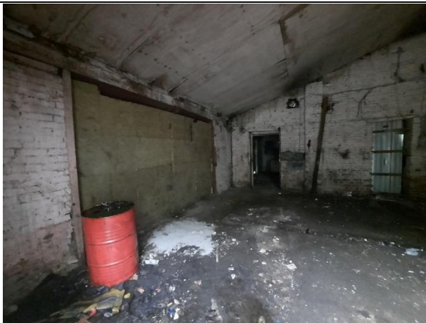
Фото № 13. Внутреннее состояние здания
