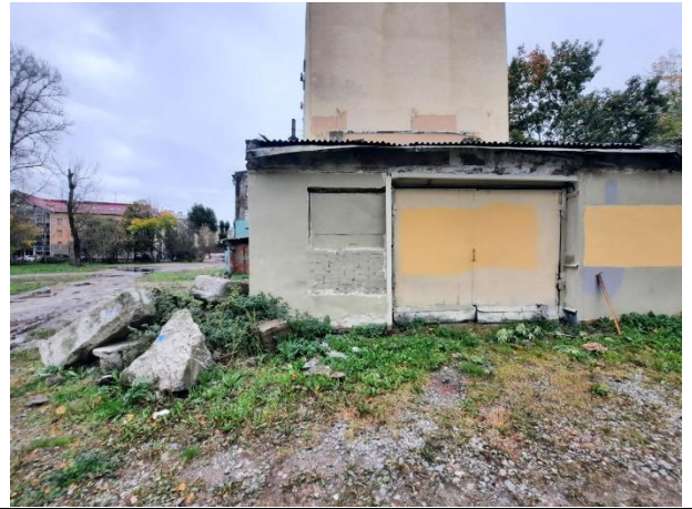
Фото № 10. Внешний вид здания
