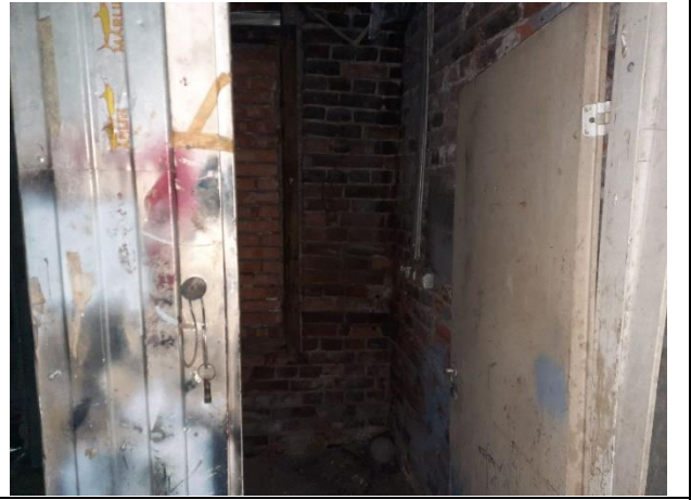
Фото № 18. Внутреннее состояние здания
