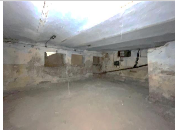
Фото 31. Типичное состояние Объекта оценки
