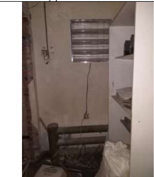
Фото 14. Внутреннее состояние Объекта оценки
