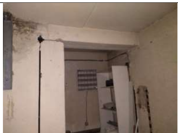
Фото 18. Внутреннее состояние Объекта оценки
