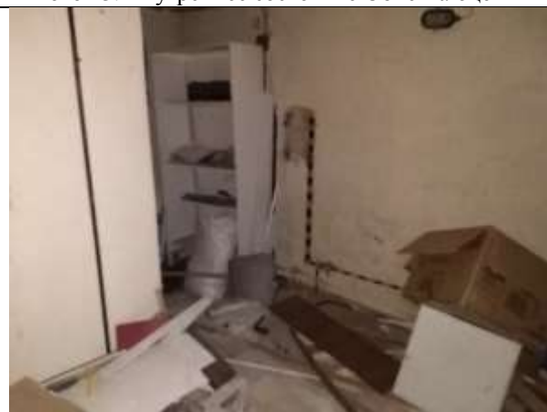
Фото 15. Внутреннее состояние Объекта оценки
