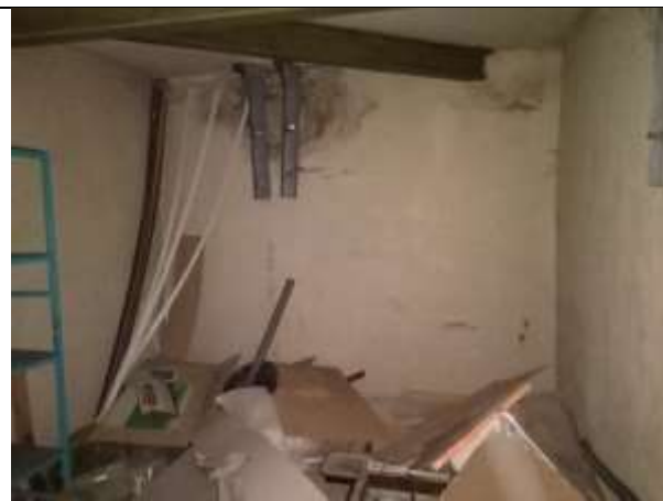
Фото 11. Внутреннее состояние Объекта оценки
