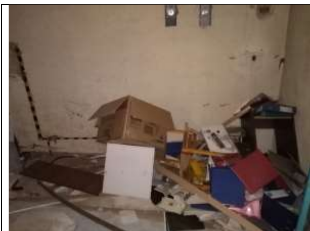
Фото 17. Внутреннее состояние Объекта оценки
