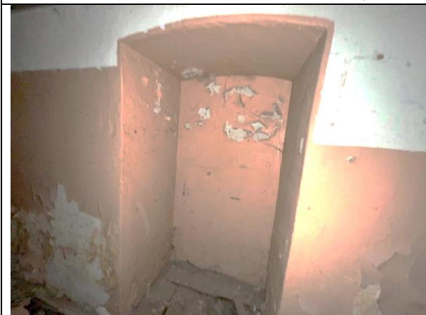
Фото 23. Типичное состояние Объекта оценки
