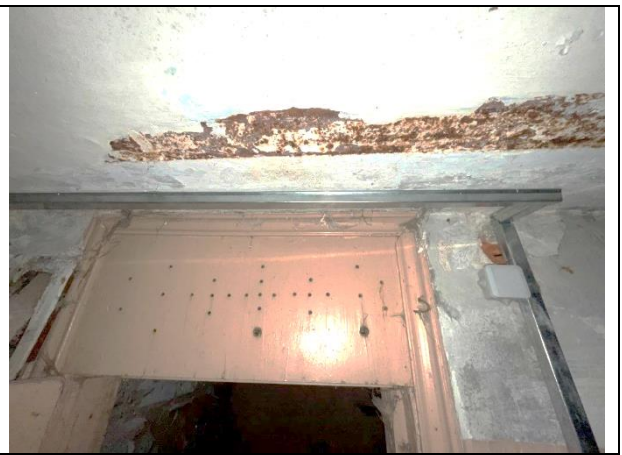
Фото 36. Типичное состояние Объекта оценки
