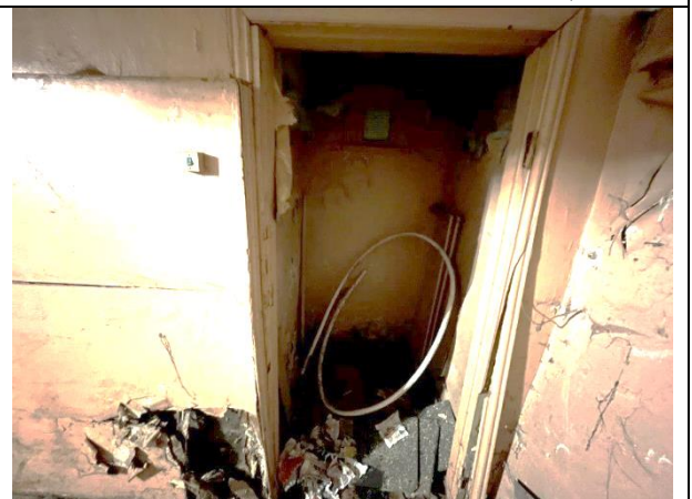
Фото 32. Типичное состояние Объекта оценки
