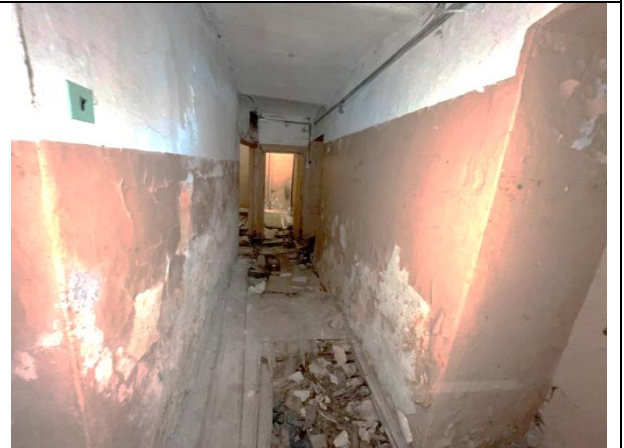
Фото 22. Типичное состояние Объекта оценки
