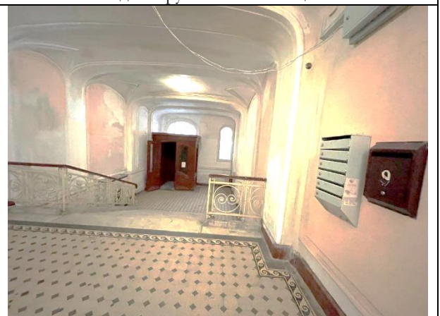
Фото 16. Лестничный проём Объекта оценки
