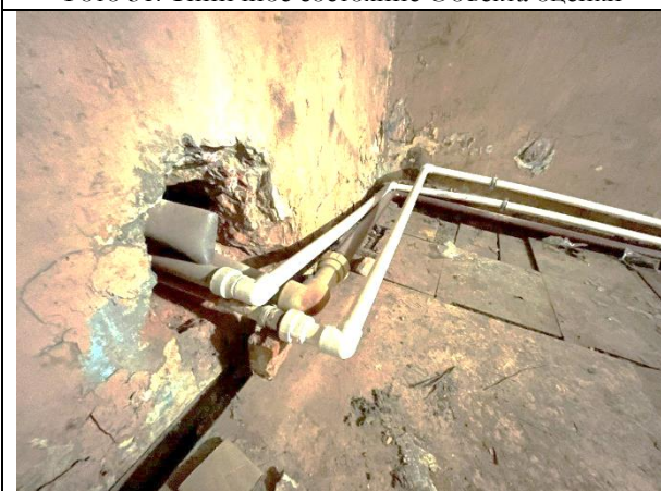
Фото 33. Типичное состояние Объекта оценки
