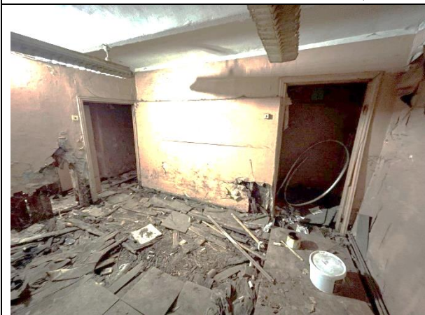
Фото 31. Типичное состояние Объекта оценки
