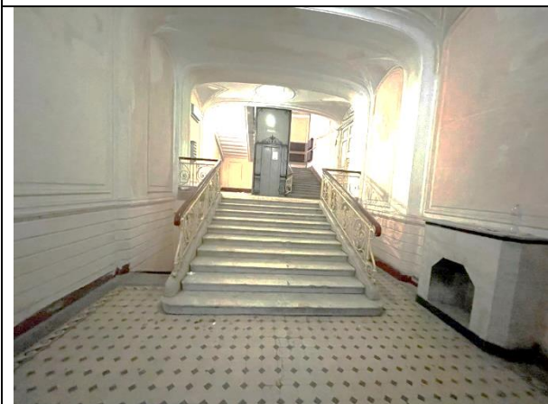
Фото 15. Лестничный проём Объекта оценки
