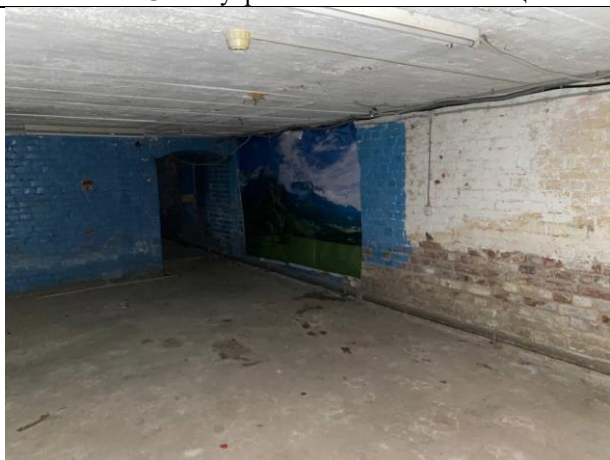
Фото № 17 – Внутреннее состояние помещения
