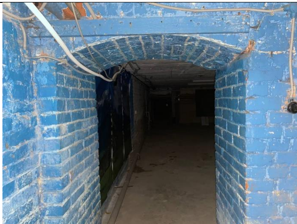
Фото № 13 – Внутреннее состояние помещения
