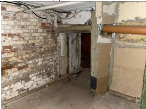
Фото № 19 – Внутреннее состояние помещения
