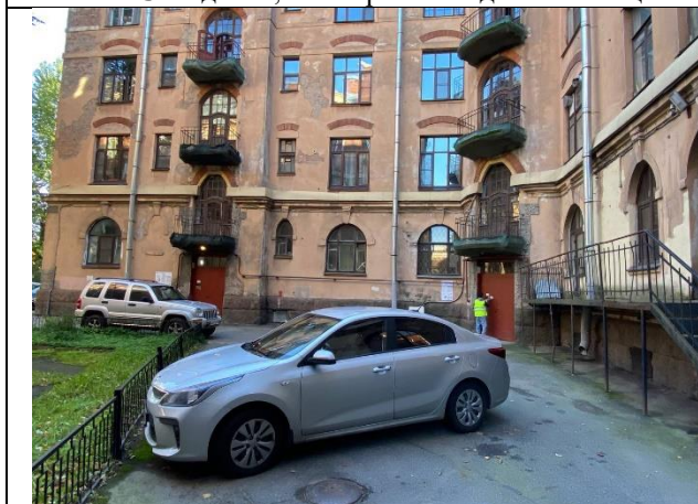
Фото № 7 – Общий вход в помещение со двора
