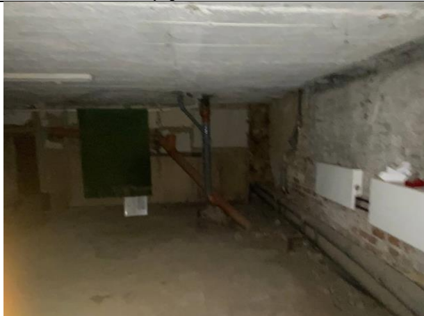
Фото № 15 – Внутреннее состояние помещения
