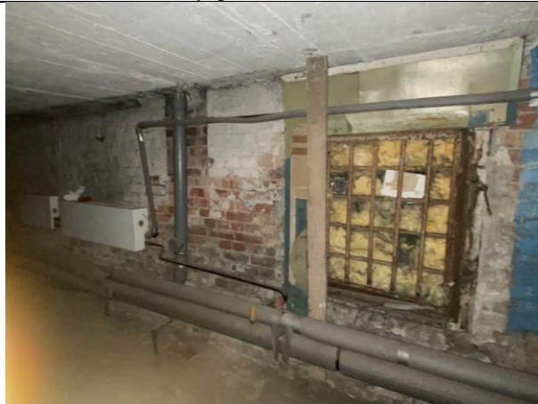
Фото № 16 – Внутреннее состояние помещения
