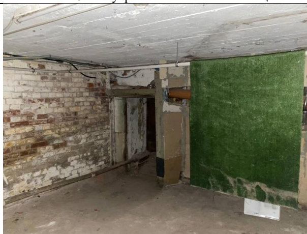
Фото № 18 – Внутреннее состояние помещения
