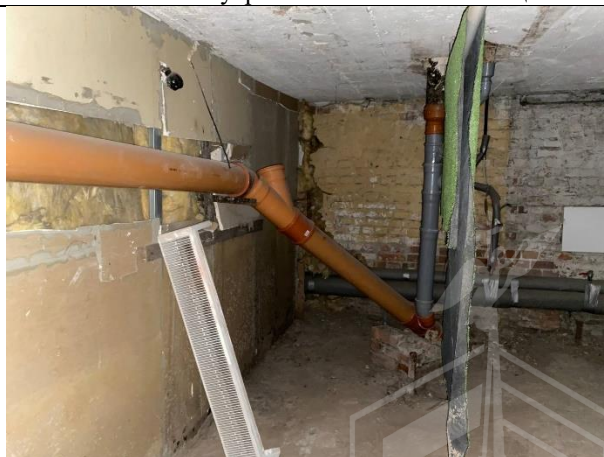
Фото № 20 – Внутреннее состояние помещения
