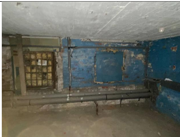
Фото № 14 – Внутреннее состояние помещения
