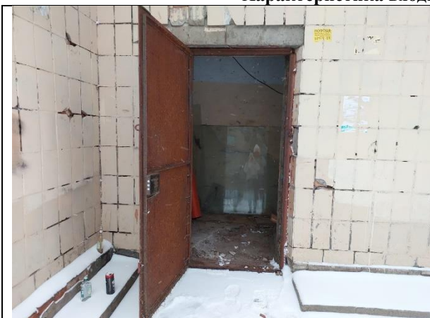
Фото 3. Общий вход Объекта оценки со двора
