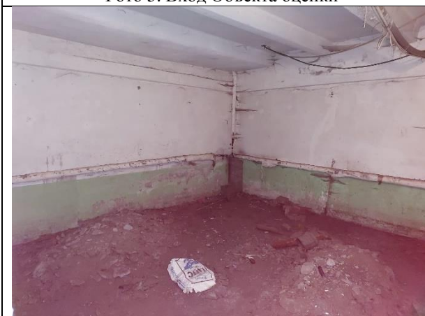
Фото 7. Внутреннее состояние Объекта оценки
