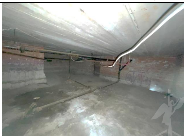
Фото 34. Типичное состояние Объекта оценки
