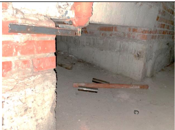
Фото 52. Типичное состояние Объекта оценки
