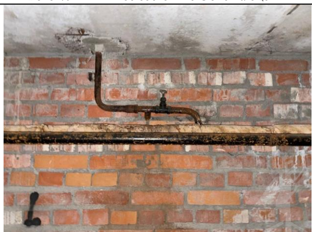
Фото 42. Типичное состояние Объекта оценки
