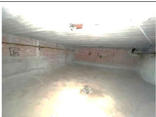
Фото 44. Типичное состояние Объекта оценки
