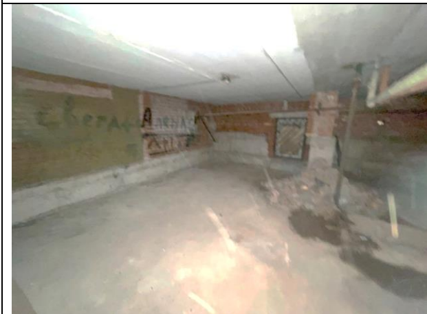
Фото 45. Типичное состояние Объекта оценки
