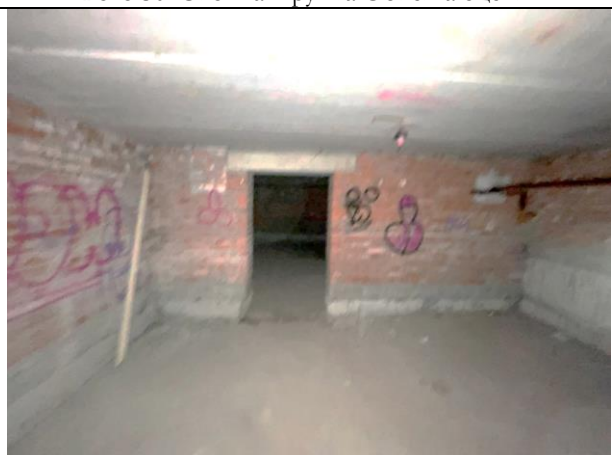
Фото 32. Типичное состояние Объекта оценки
