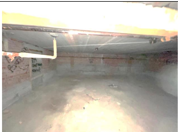
Фото 38. Типичное состояние Объекта оценки
