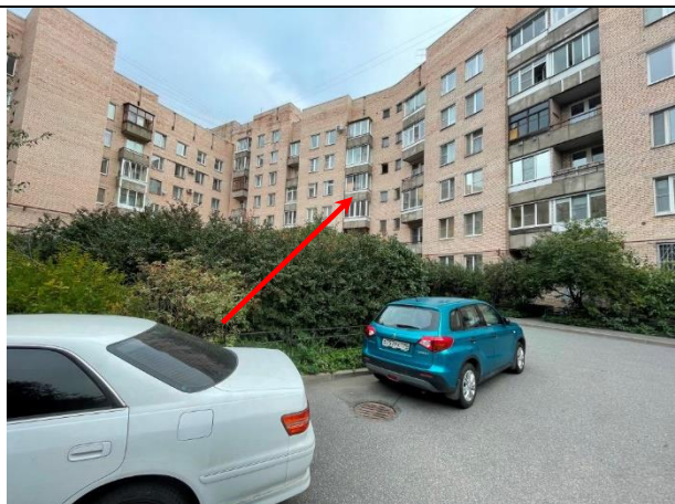
Фото 22. Вид здания расположения Объекта оценки
