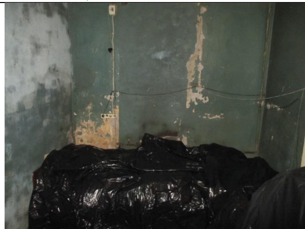
Фото 8. Внутреннее состояние Объекта оценки
