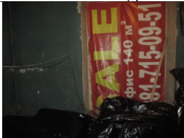
Фото 7. Внутреннее состояние Объекта оценки
