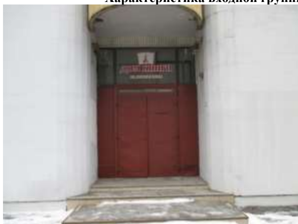
Фото 3. Отдельный вход с улицы
