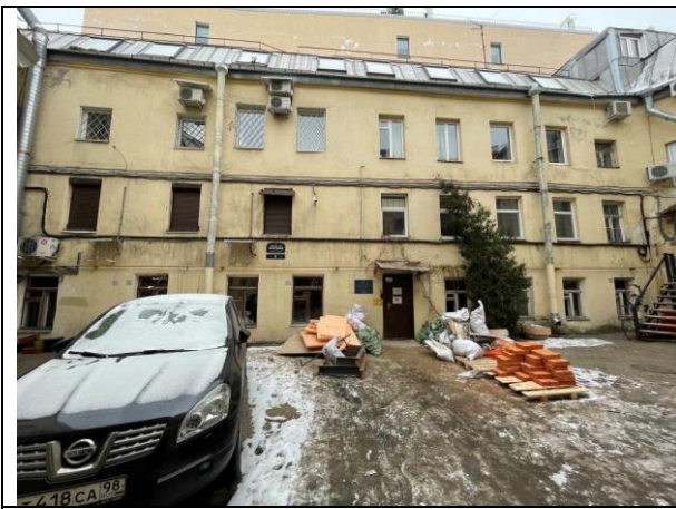
Фото 15. Внутривдворовая территория Объекта оценки
