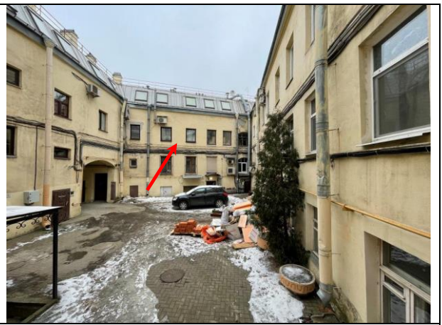
Фото 16. Вид здания расположения Объекта оценки
