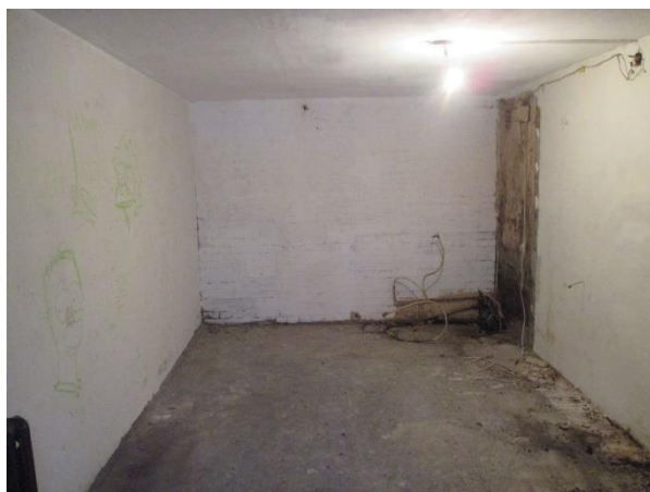
Фото 7. Внутреннее состояние Объекта оценки
