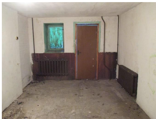
Фото 8. Внутреннее состояние Объекта оценки
