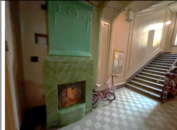
Фото 19. Лестничный проём Объекта оценки
