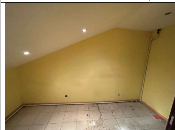
Фото 23. Типичное состояние Объекта оценки
