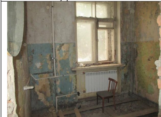
Фото № 9 – Внутреннее состояние помещения
