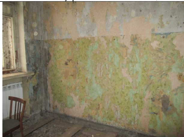
Фото № 10 – Внутреннее состояние помещения
