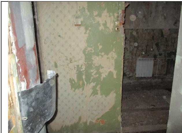
Фото № 7 – Внутреннее состояние помещения
