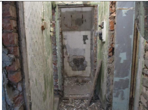
Фото № 8 – Внутреннее состояние помещения
