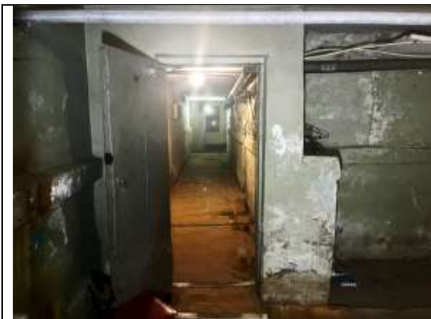
Фото 21. Внутреннее состояние Объекта оценки
