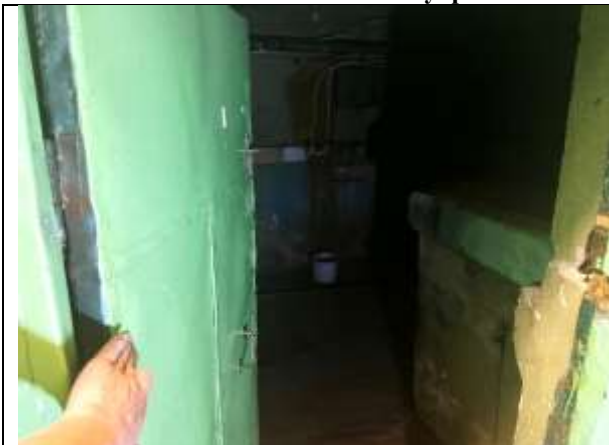
Фото 7. Внутреннее состояние Объекта оценки
