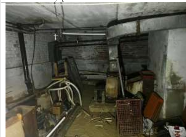
Фото 23. Внутреннее состояние Объекта оценки
