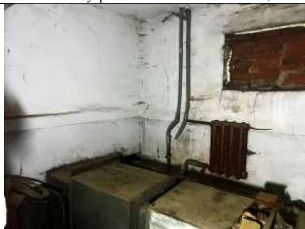
Фото 24. Внутреннее состояние Объекта оценки
