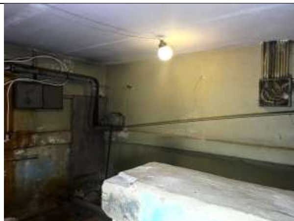
Фото 22. Внутреннее состояние Объекта оценки
