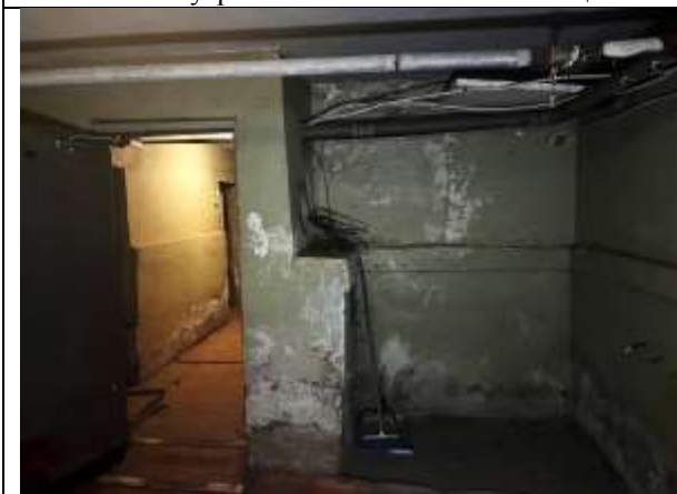
Фото 9. Внутреннее состояние Объекта оценки
