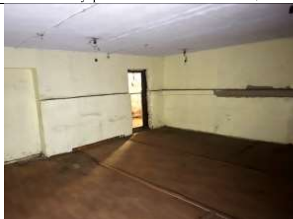
Фото 10. Внутреннее состояние Объекта оценки
