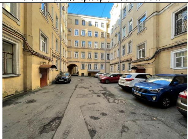
Фото 28. Внутридворовая территория Объекта оценки
