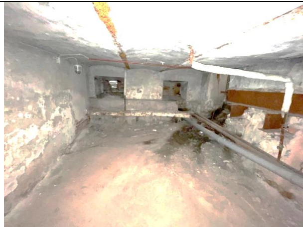
Фото 41. Типичное состояние Объекта оценки
