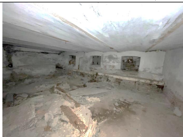
Фото 43. Типичное состояние Объекта оценки
