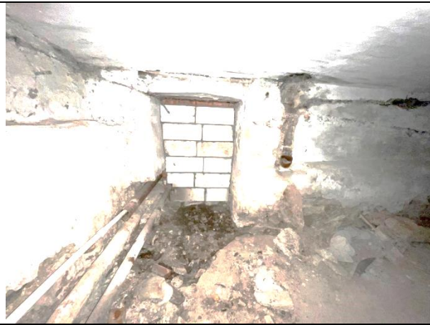
Фото 39. Типичное состояние Объекта оценки
