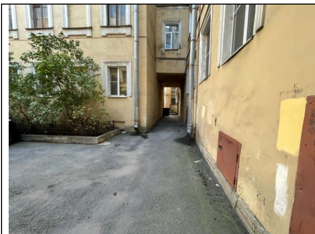
Фото 31. Внутридворовая территория Объекта оценки
