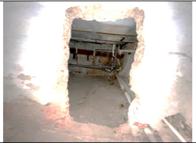
Фото 40. Типичное состояние Объекта оценки
