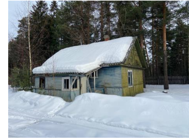
Фото № 10. Внешний вид здания литеры Ж
