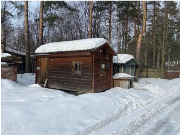
Фото № 9. Внешний вид здания литеры К
