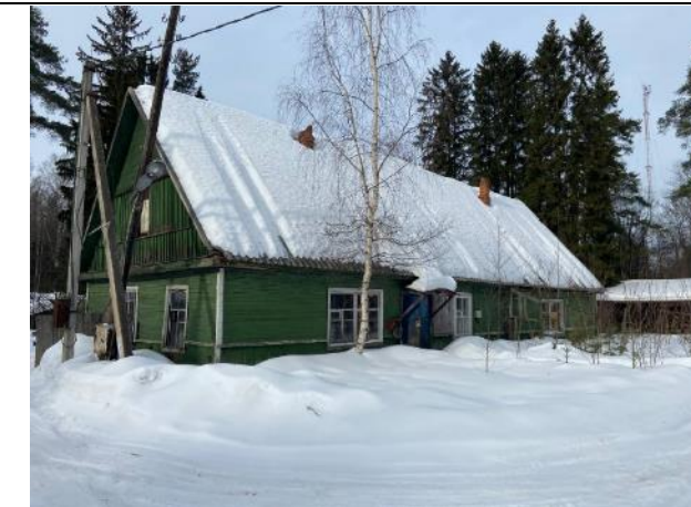
Фото № 12. Внешний вид здания литеры В
