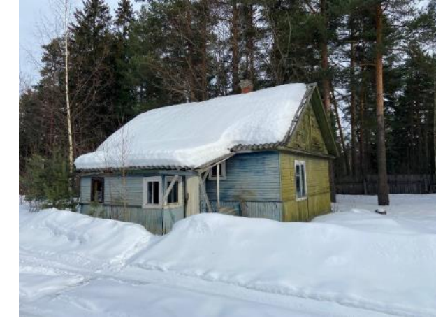
Фото № 10. Внешний вид здания литеры Ж
