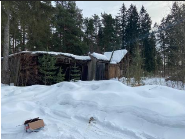
Фото № 13. Внешний вид здания литеры Е и земельного участка
