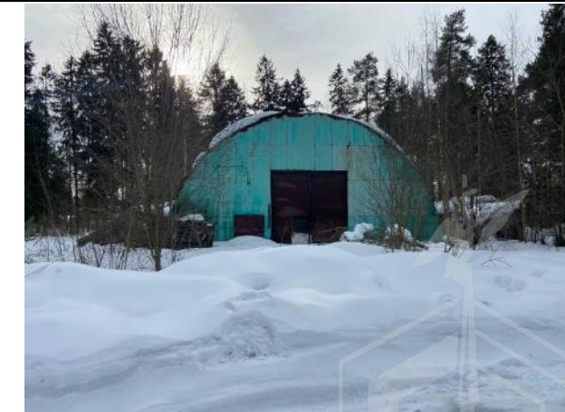
Фото № 14. Внешний вид здания литеры Б и земельного участка
