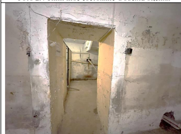
Фото 31. Типичное состояние Объекта оценки
