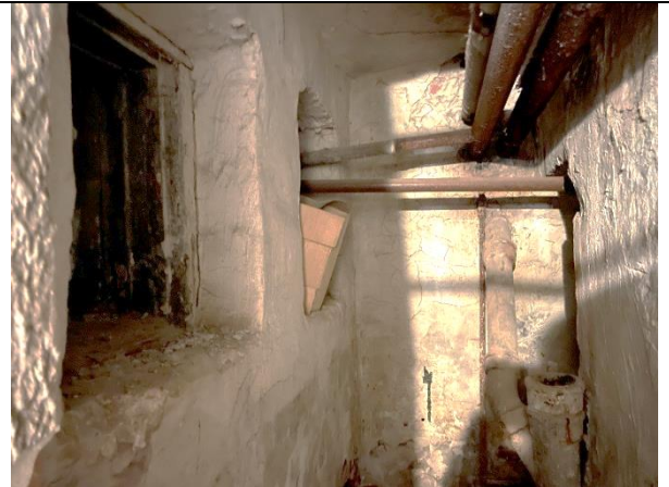
Фото 44. Типичное состояние Объекта оценки
