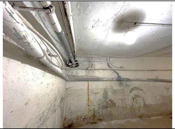
Фото 34. Типичное состояние Объекта оценки
