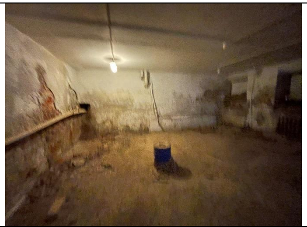
Фото 42. Типичное состояние Объекта оценки
