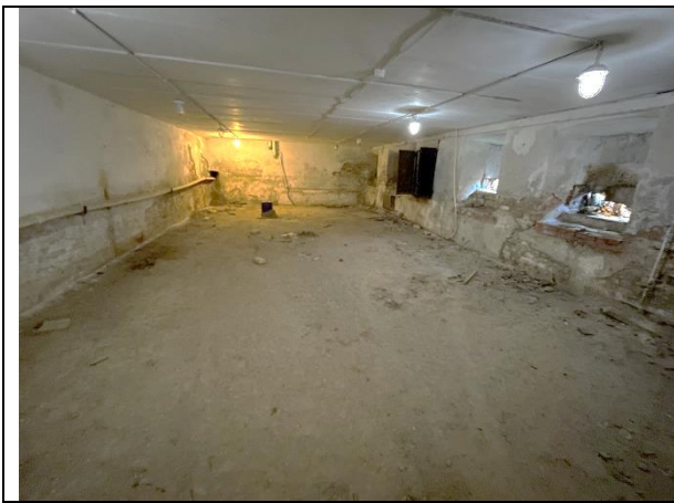
Фото 41. Типичное состояние Объекта оценки
