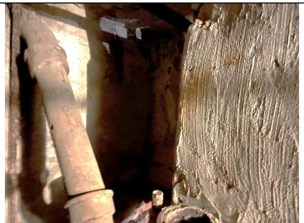
Фото 46. Типичное состояние Объекта оценки
