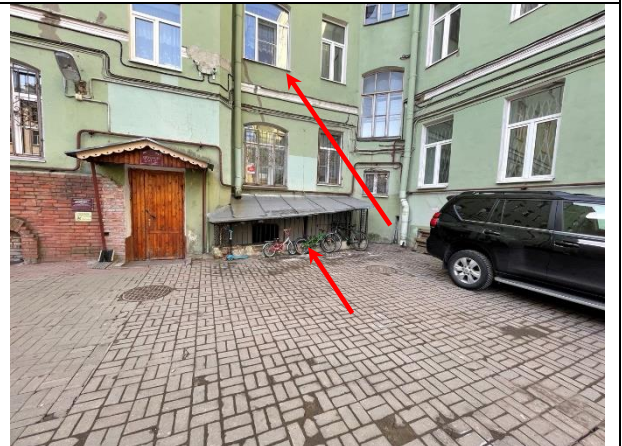
Фото 20. Вид здания расположения Объекта оценки
