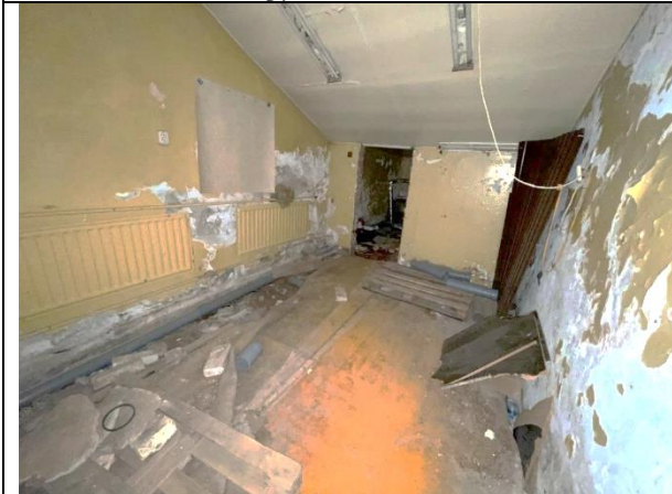
Фото 25. Типичное состояние Объекта оценки
