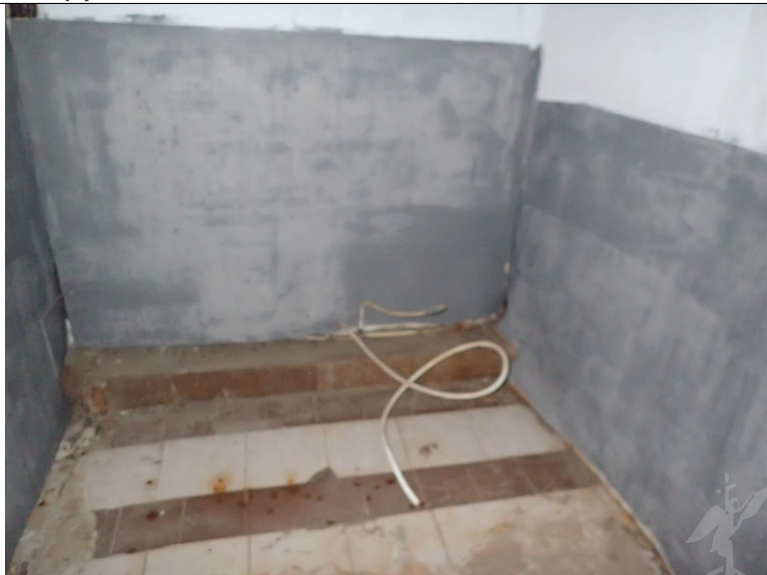
Описание: Вид внутри Объекта
