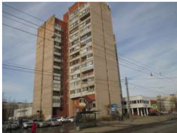
Фото 2. Вид здания, в котором расположен Объект оценки
