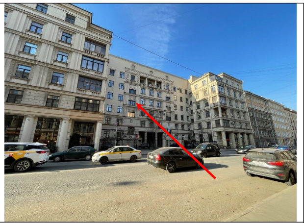
Фото 18. Вид здания расположения Объекта оценки
