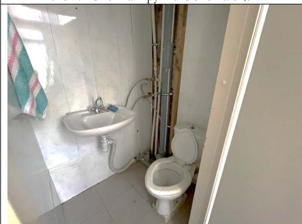
Фото 31. Типичное состояние Объекта оценки
