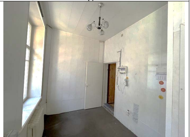
Фото 28. Типичное состояние Объекта оценки
