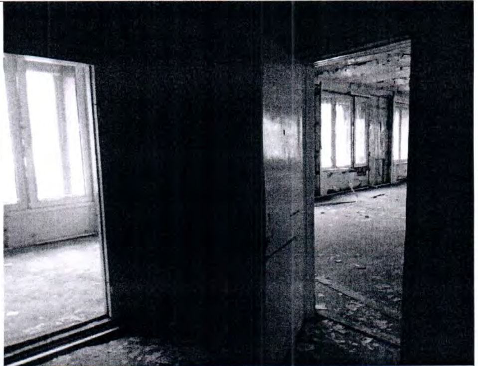
Описание: Вид внутри Объекта
