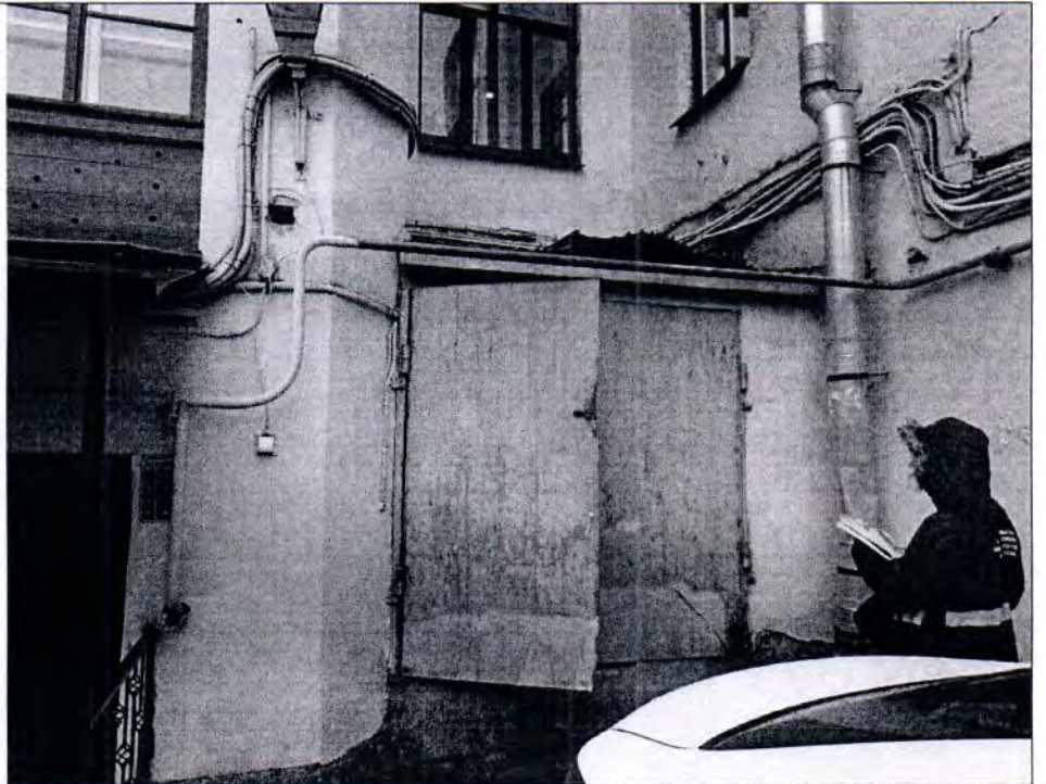
Описание: Вход на Объект со двора
