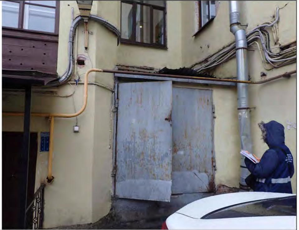
Описание: Вход на Объект со двора
