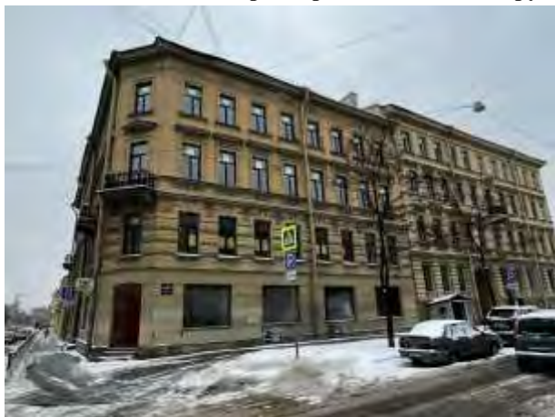
Фото 5. 1 отдельный вход с улицы и окна Объекта оценки
