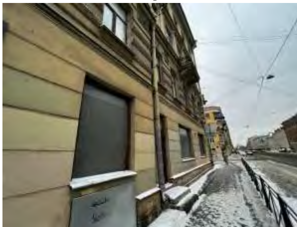
Фото 6. 1 отдельный вход с улицы и окна Объекта оценки
