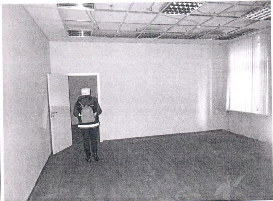
Описание: в ч.п. 3 Объекта оборудована перегородка с дверным проемом
