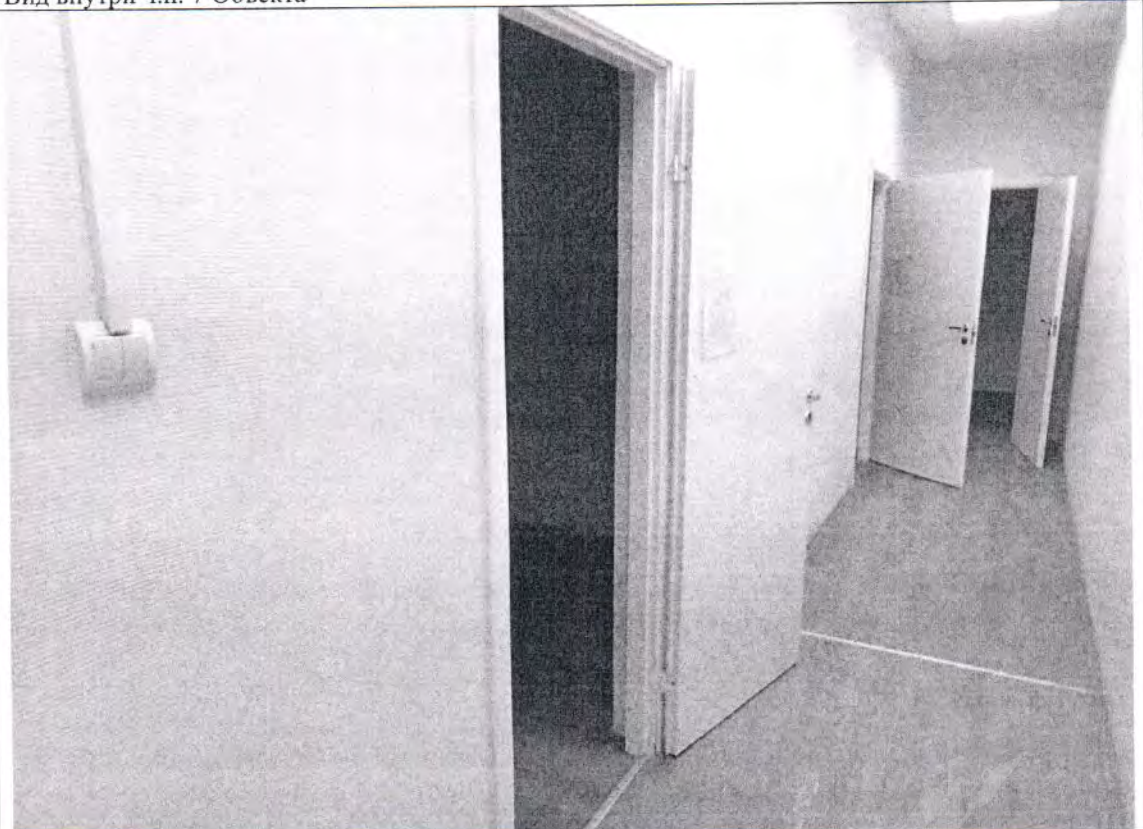
Описание: между ч.п. 11 и 12 Объекта оборудован дверной проем
