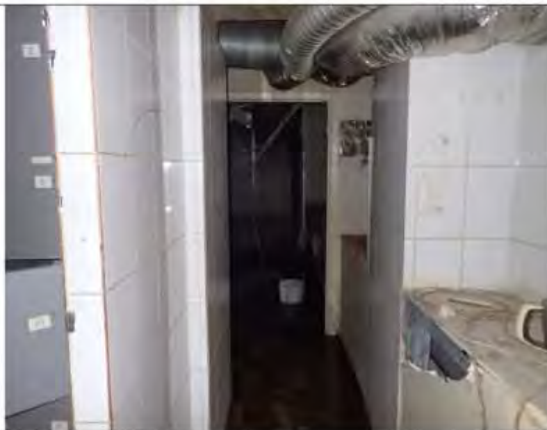
Описание: Вид внутри Объекта
