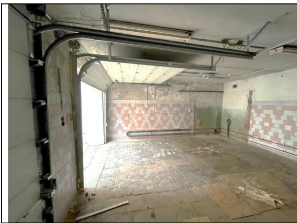
Фото 21. Типичное состояние Объекта оценки
