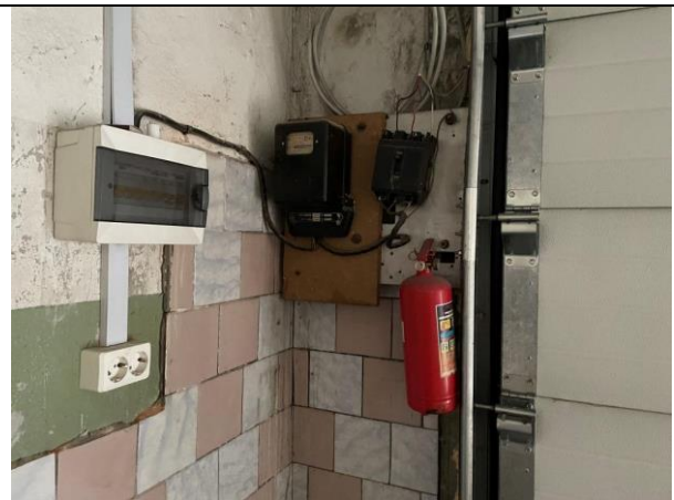
Фото 24. Типичное состояние Объекта оценки
