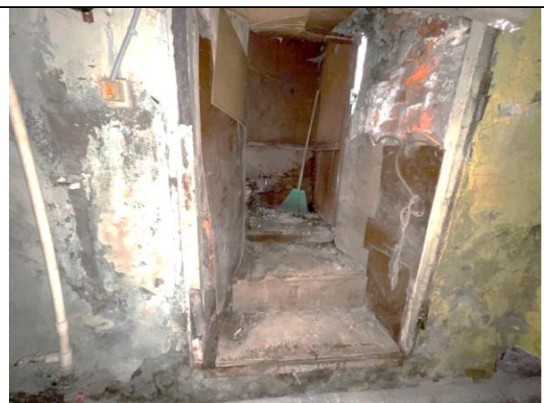
Фото 54. Типичное состояние объекта оценки (пом. 2-Н)
