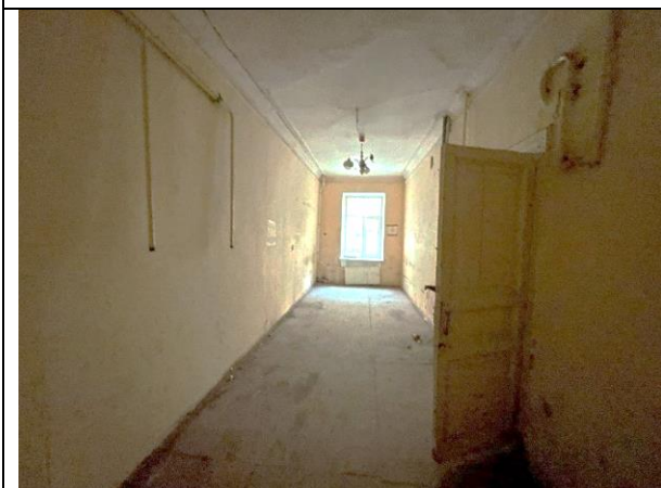
Фото 35. Типичное состояние Объекта оценки
