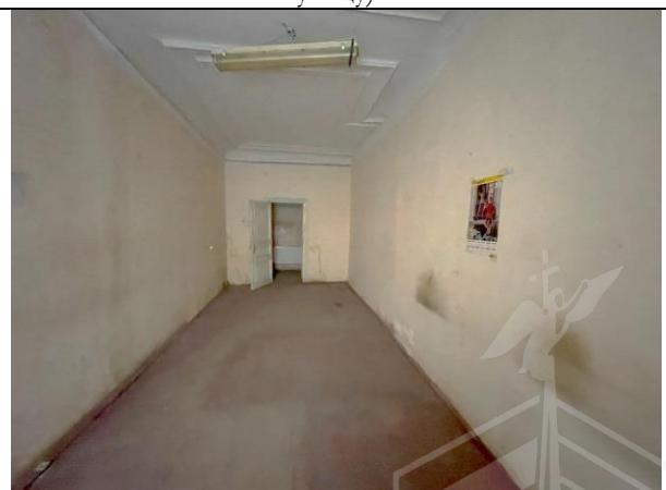
Фото 36. Типичное состояние Объекта оценки
