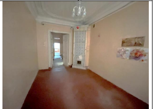
Фото 24. Типичное состояние Объекта оценки
