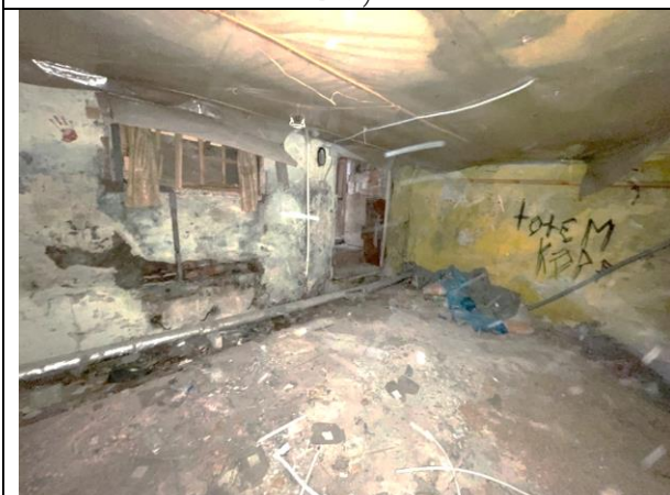
Фото 55. Типичное состояние объекта оценки (пом. 2-Н)
