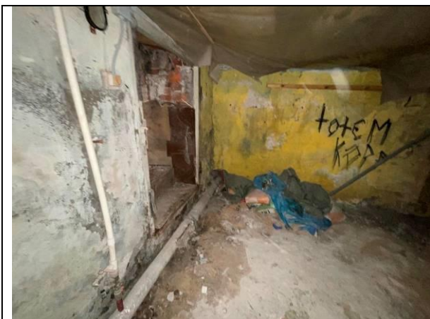
Фото 53. Типичное состояние объекта оценки (пом. 2-Н)
