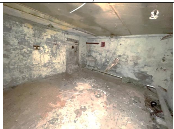
Фото 56. Типичное состояние объекта оценки (пом. 2-Н)
