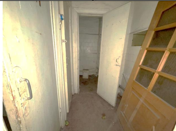
Фото 39. Типичное состояние Объекта оценки
