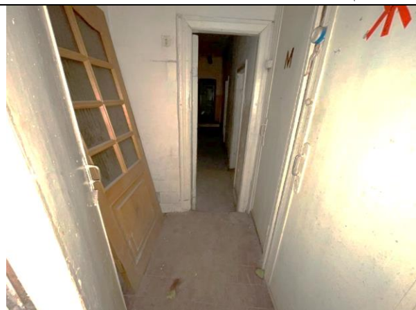
Фото 43. Типичное состояние Объекта оценки
