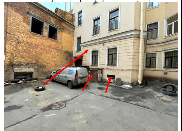
Фото 50. Вид здания расположения Объекта оценки (входная и оконная группа Объекта оценки, вход отдельный со двора через приямок, пом.2-Н
