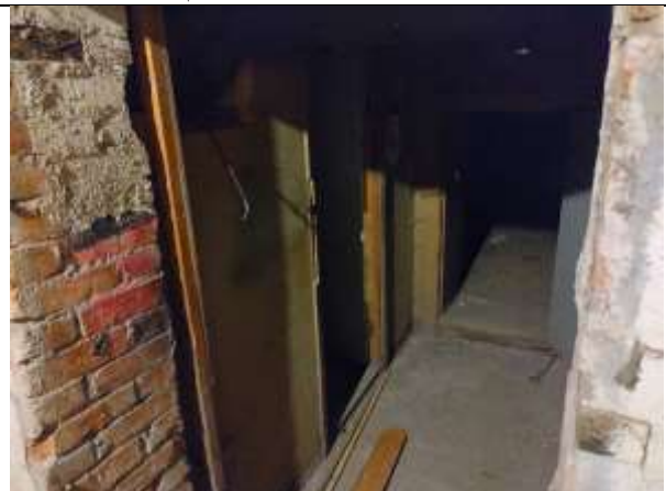
Фото 8. Внутреннее состояние Объекта оценки
