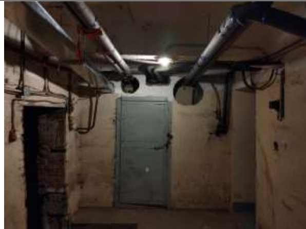
Фото 11. Внутреннее состояние Объекта оценки
