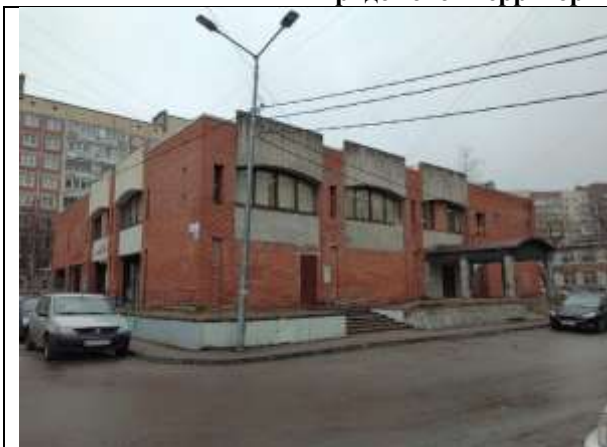
Фото 1. Вид здания, в котором расположен Объект оценки
