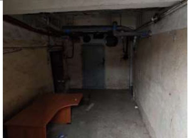
Фото 12. Внутреннее состояние Объекта оценки
