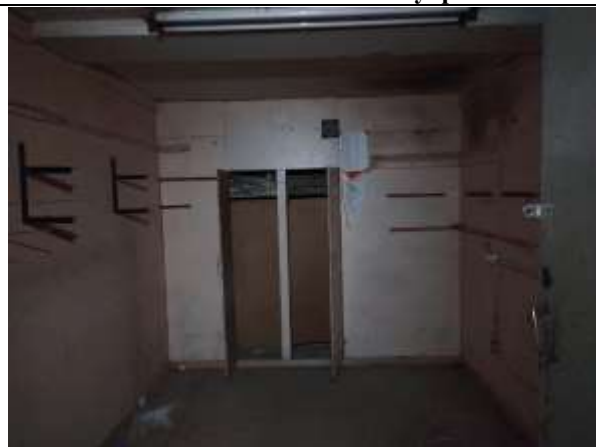
Фото 7. Внутреннее состояние Объекта оценки
