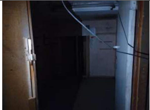
Фото 10. Внутреннее состояние Объекта оценки
