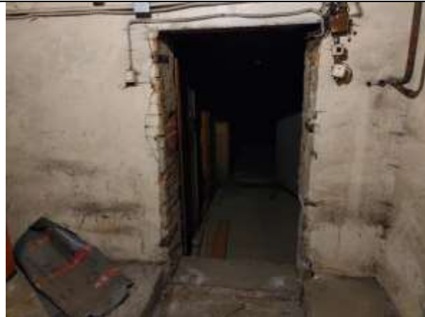
Фото 9. Внутреннее состояние Объекта оценки
