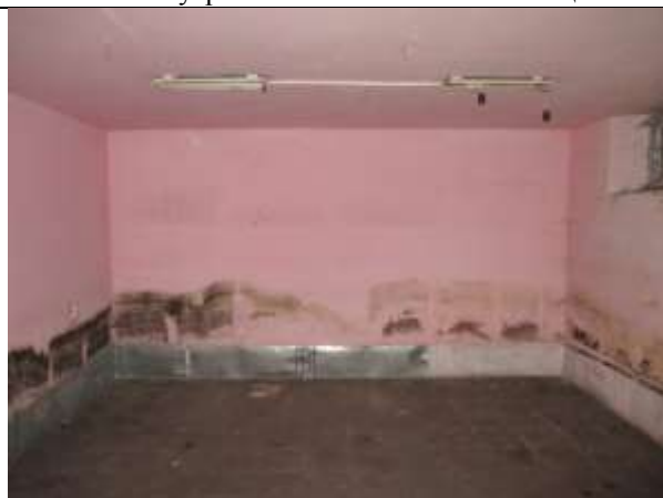
Фото 9. Внутреннее состояние Объекта оценки
