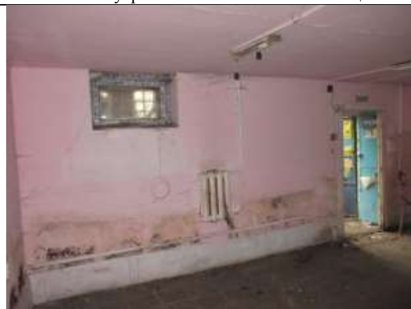
Фото 10. Внутреннее состояние Объекта оценки
