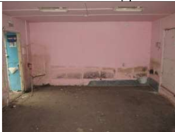
Фото 7. Внутреннее состояние Объекта оценки
