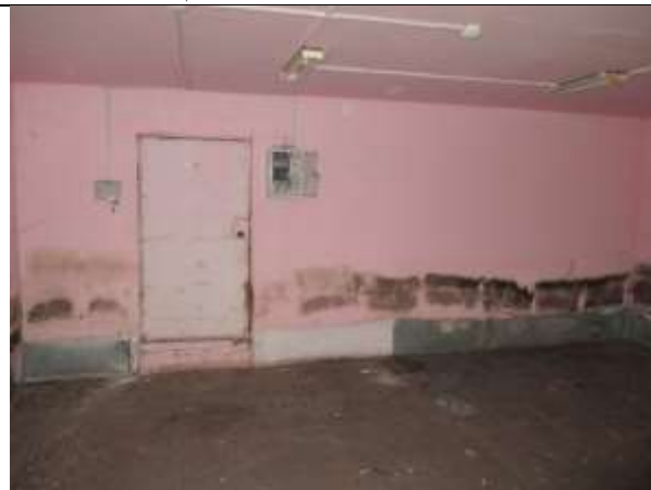
Фото 8. Внутреннее состояние Объекта оценки
