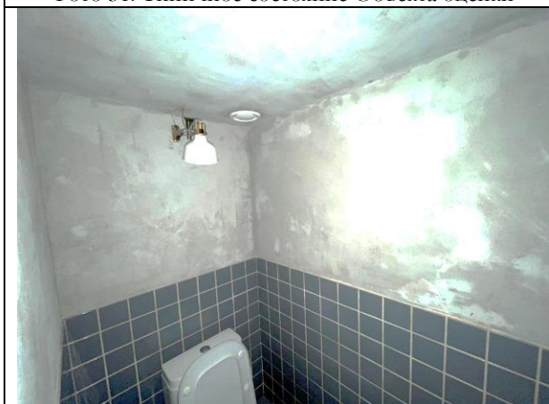
Фото 33. Типичное состояние Объекта оценки
