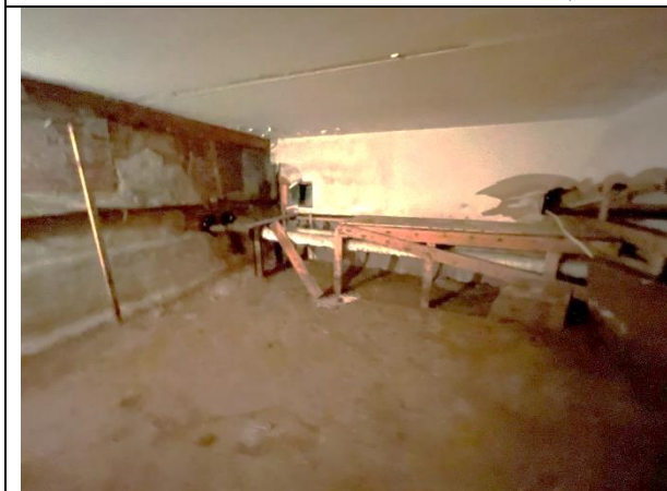
Фото 23. Типичное состояние Объекта оценки
