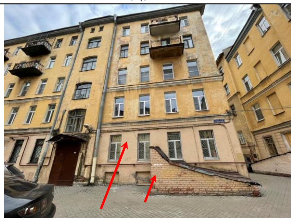
Фото 17. Вид здания расположения Объекта оценки, входная группа Объекта оценки, помещение 2-Н
