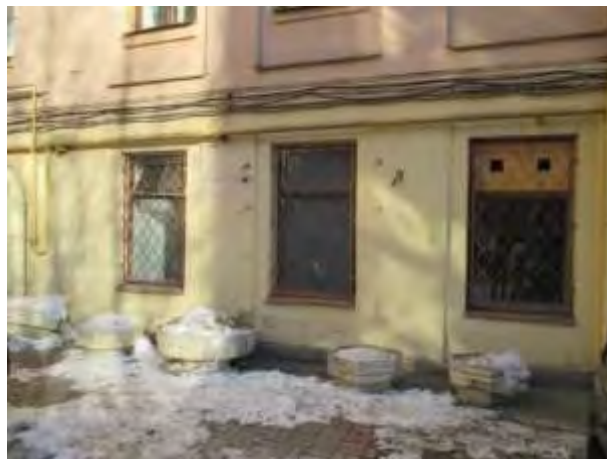
Фото 8. Вид оконных проемов Объекта оценки, ориентация – во двор
