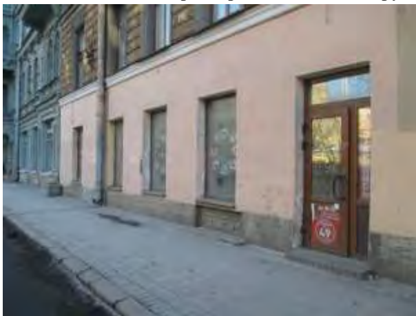
Фото 5. 1 отдельный вход с улицы и окна Объекта оценки
