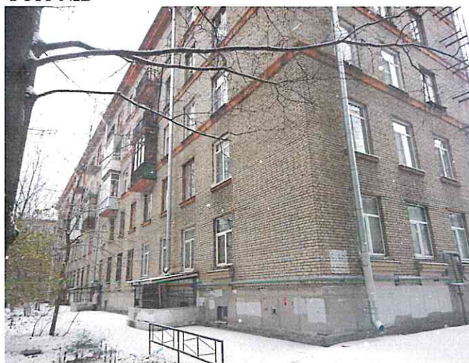
Фото №4 (вход в помещение)
