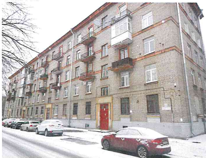
Фото №3 (отдельный со двора через приямок)
