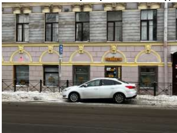
Фото 3. 1 отдельный вход с улицы и окна Объекта оценки
