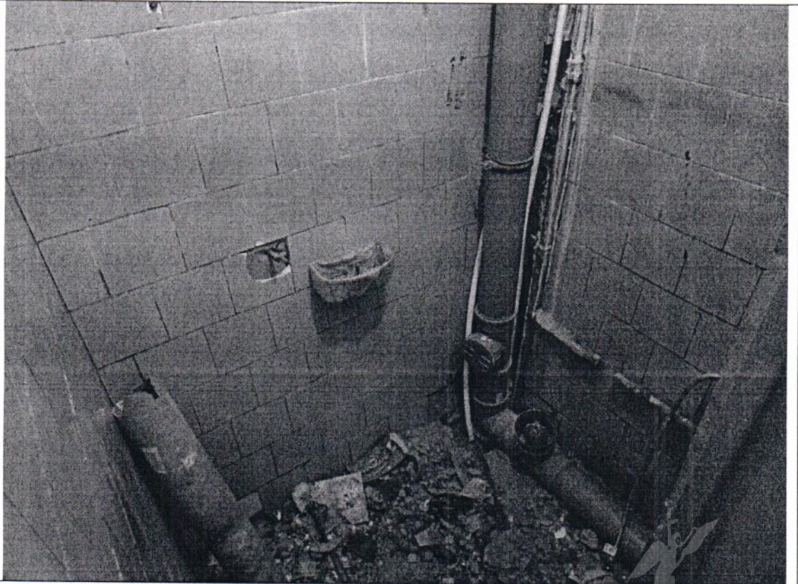
Описание: в ч.п. 4 Объекта демонтировано сантехническое оборудование (унитаз)
