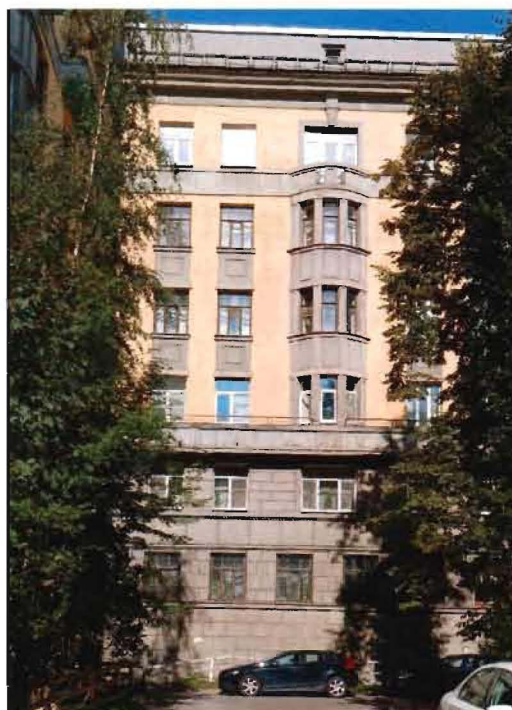
4. Фрагмент. Восточный фасад главного флигеля.
