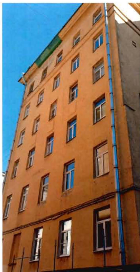
8. Фрагмент. Западный фасад северного флигеля.
