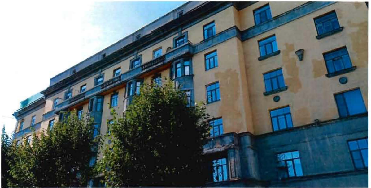
5. Фрагмент. Восточный фасад южного флигеля.
