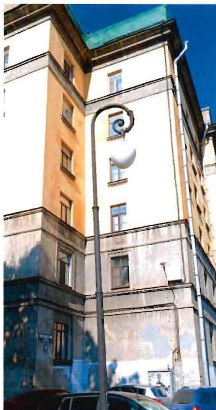
7. Фрагмент. Северный фасад южного флигеля.
