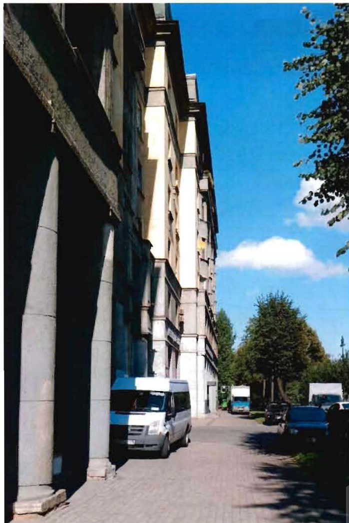
6. Фрагмент. Восточный фасад южного флигеля.
