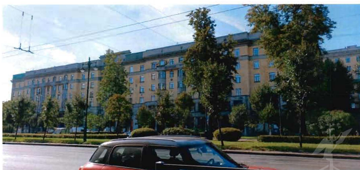
2. Общий вид. Восточный фасад южного флигеля.
