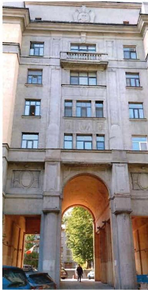
3. Фрагмент. Восточный фасад южного флигеля.
