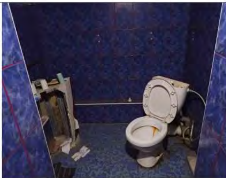
Описание: Вид внутри Объекта (ч.п.4), установлен унитаз
