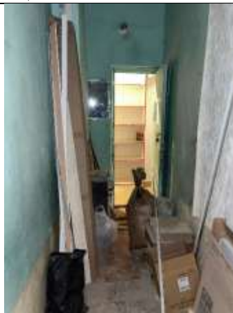
Фото 10. Внутреннее состояние Объекта оценки
