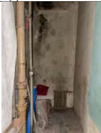
Фото 11. Внутреннее состояние Объекта оценки
