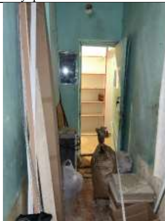
Фото 12. Внутреннее состояние Объекта оценки
