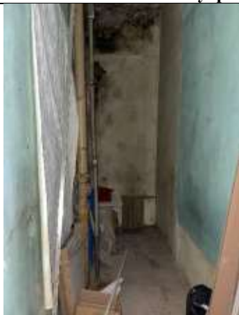
Фото 9. Внутреннее состояние Объекта оценки
