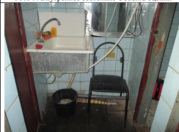
Фото 11. Внутреннее состояние Объекта оценки
