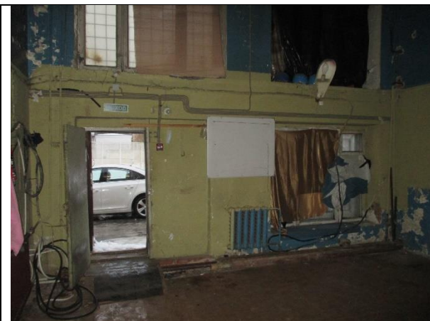
Фото 9. Внутреннее состояние Объекта оценки
