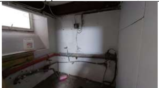
Фото 22. Внутреннее состояние Объекта оценки
