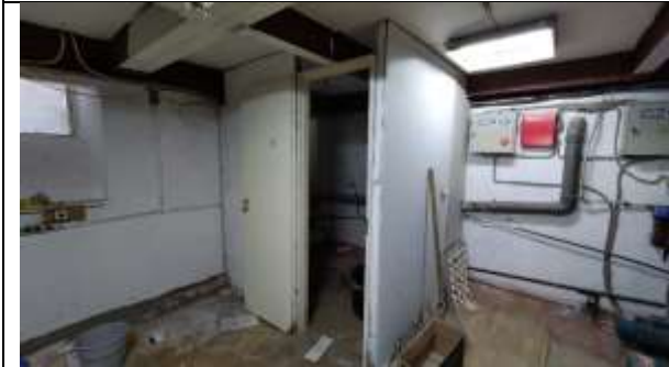
Фото 23. Внутреннее состояние Объекта оценки
