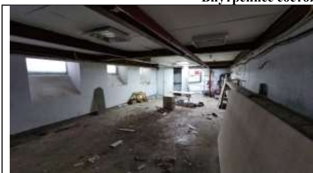
Фото 11. Внутреннее состояние Объекта оценки
