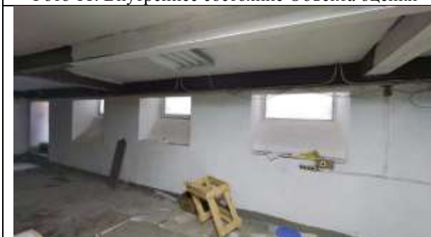
Фото 13. Внутреннее состояние Объекта оценки
