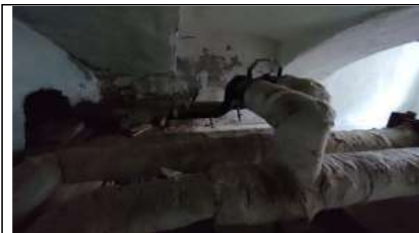
Фото 17. Внутреннее состояние Объекта оценки
