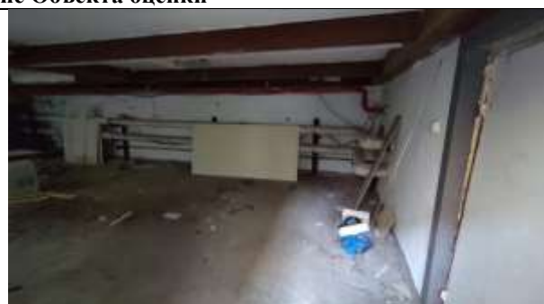
Фото 12. Внутреннее состояние Объекта оценки
