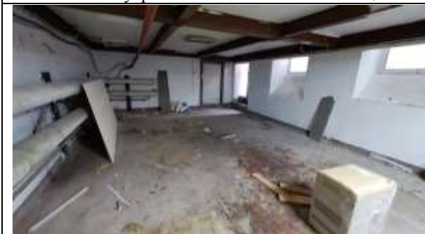
Фото 21. Внутреннее состояние Объекта оценки
