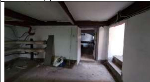
Фото 19. Внутреннее состояние Объекта оценки
