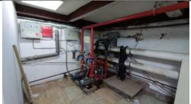
Фото 24. Внутреннее состояние Объекта оценки
