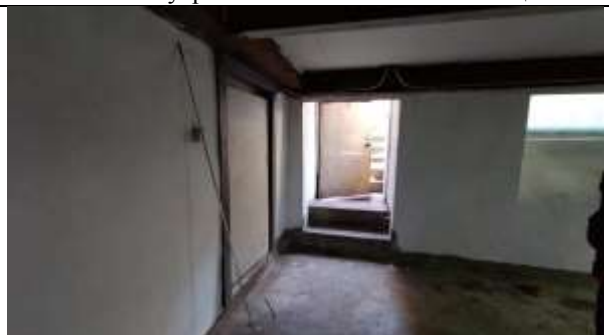
Фото 20. Внутреннее состояние Объекта оценки
