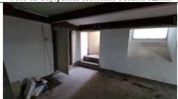
Фото 14. Внутреннее состояние Объекта оценки
