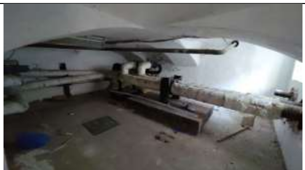
Фото 18. Внутреннее состояние Объекта оценки
