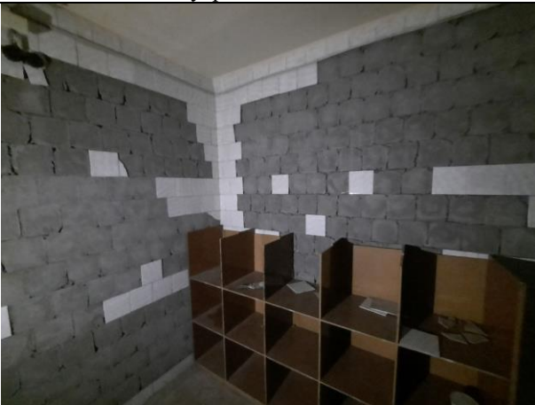
Фото № 13 – Внутреннее состояние помещения
