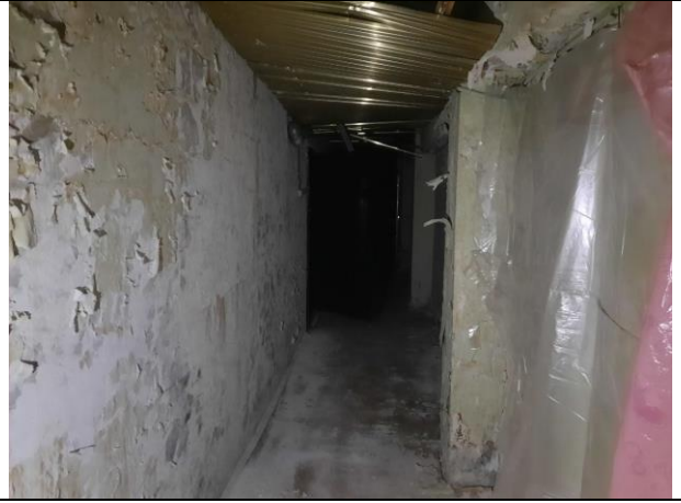
Фото № 10 – Внутреннее состояние помещения
