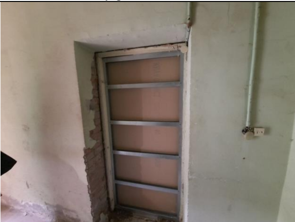
Фото № 15 – Внутреннее состояние помещения
