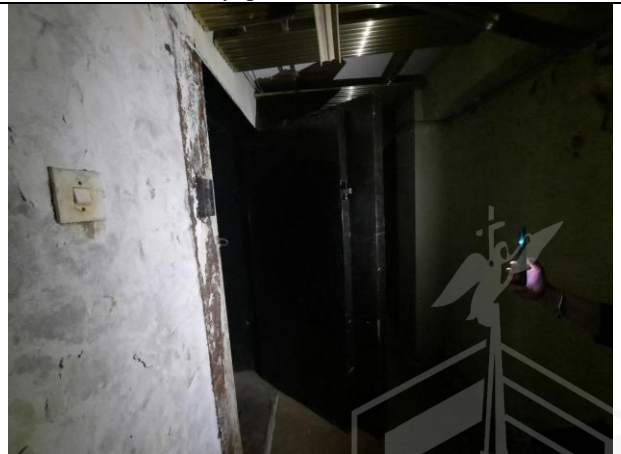
Фото № 16 – Внутреннее состояние помещения
