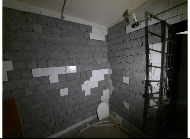
Фото № 12 – Внутреннее состояние помещения
