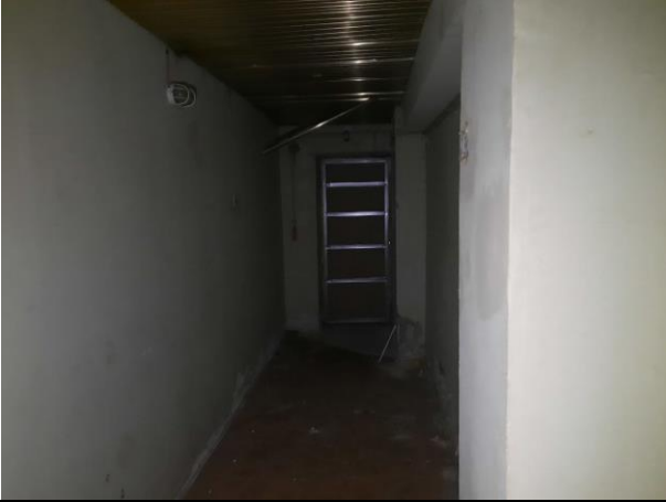
Фото № 11 – Внутреннее состояние помещения
