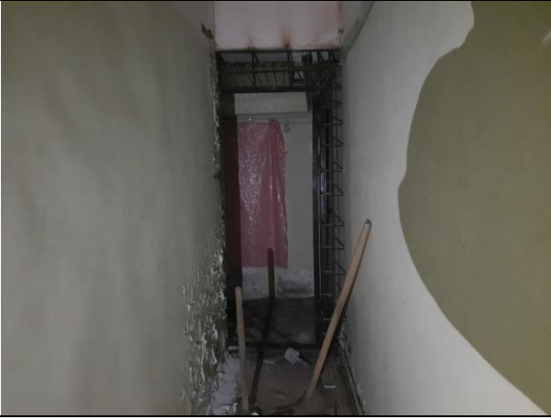
Фото № 9 – Внутреннее состояние помещения
