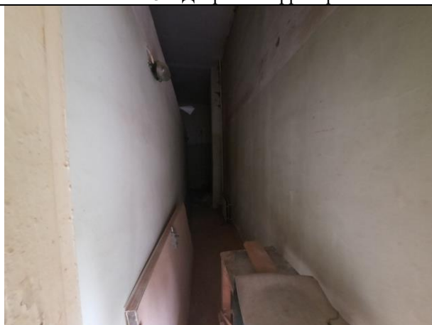
Фото № 7 – Внутреннее состояние помещения
