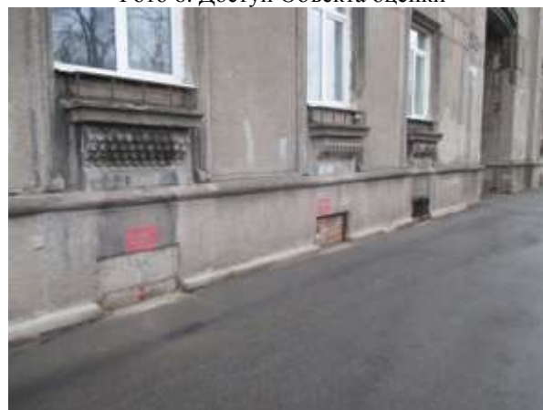
Фото 8. Вид окон Объекта оценки
