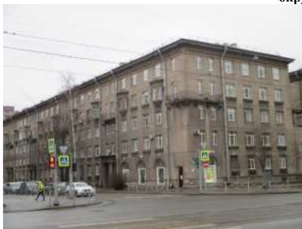
Фото 1. Вид здания Объекта оценки, с улицы
