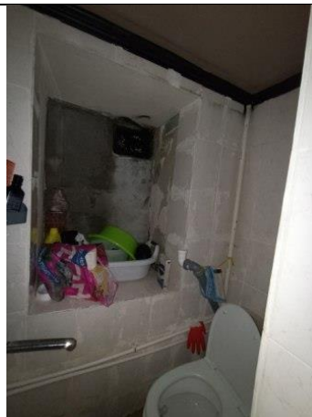
Фото № 16 – Внутреннее состояние помещения
