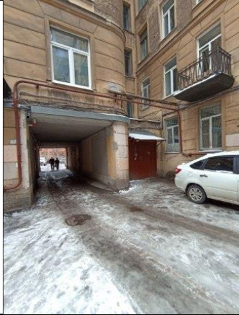
Фото № 7 – Вход общий со двора
