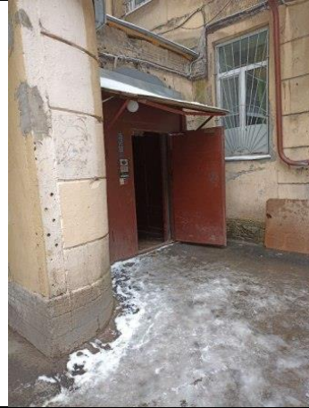
Фото № 8 – Вход общий со двора
