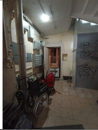
Фото № 10 – Вход в помещение
