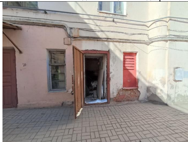
Фото № 6 – Внутреннее состояние помещения
