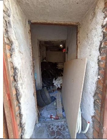
Фото № 8 – Внутреннее состояние помещения
