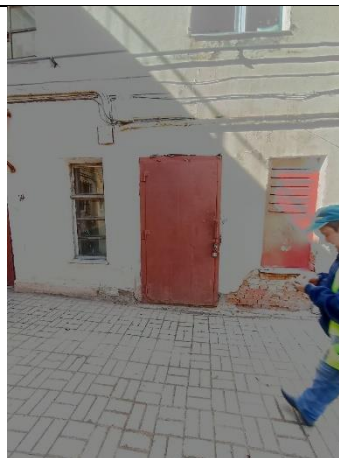
Фото № 4 – Вход в помещение со двора
