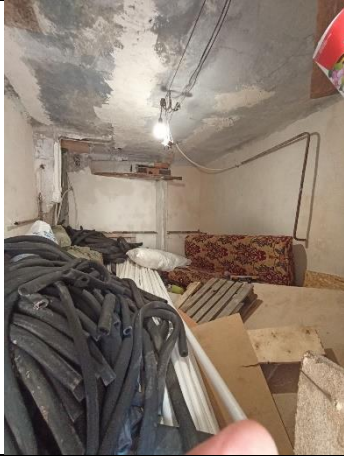
Фото № 7 – Внутреннее состояние помещения
