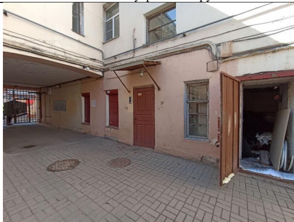
Фото № 5 – Вход в помещение со двора
