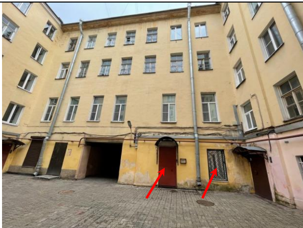
Фото 21. Проход через арку к Объекту оценки, вид здания расположения Объекта оценки, входная группа и оконная группа Объекта оценки
