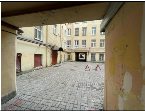
Фото 19. Внутривортовая территория Объекта оценки
