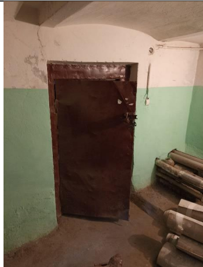
Фото № 8 – Вход в помещение
