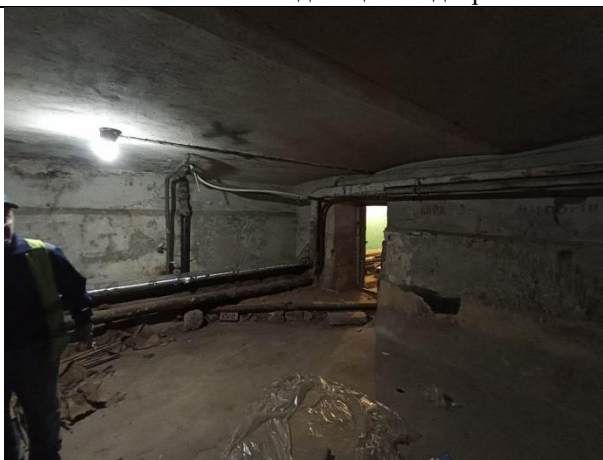
Фото № 9 – Внутреннее состояние помещения
