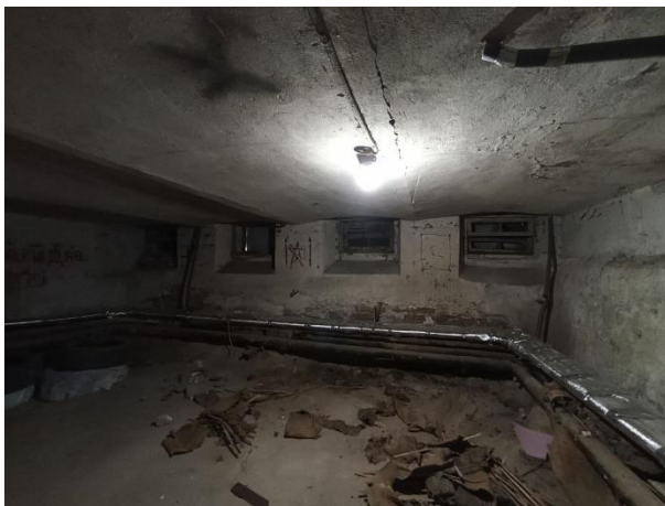
Фото № 11 – Внутреннее состояние помещения
