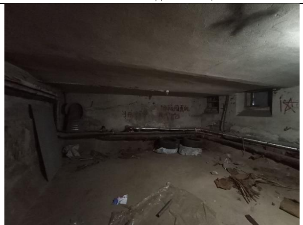
Фото № 10 – Внутреннее состояние помещения
