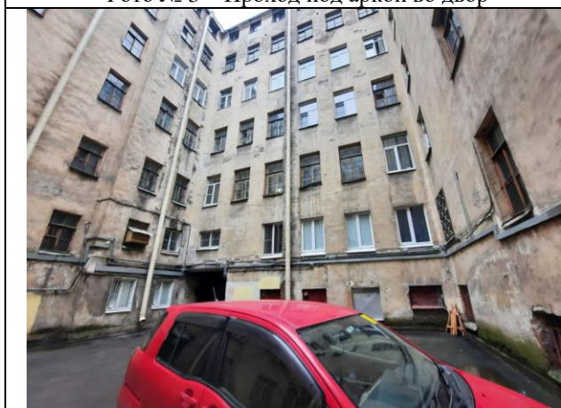
Фото № 5 – Здание, в котором находится Объект оценки
