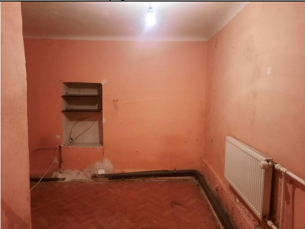
Фото № 13 – Внутреннее состояние помещения
