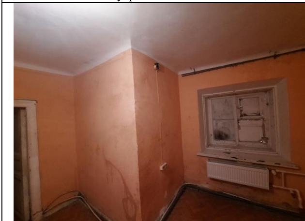
Фото № 17 – Внутреннее состояние помещения
