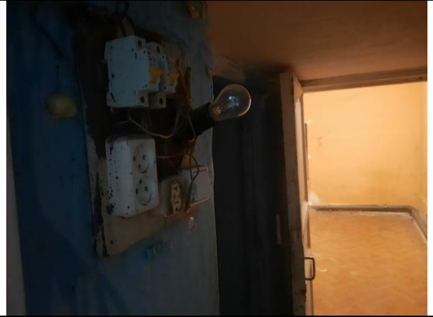
Фото № 8 – Внутреннее состояние помещения
