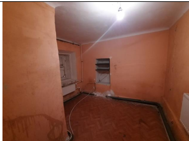
Фото № 16 – Внутреннее состояние помещения
