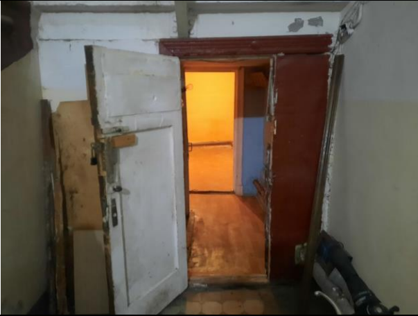
Фото № 7 – Вход в помещение
