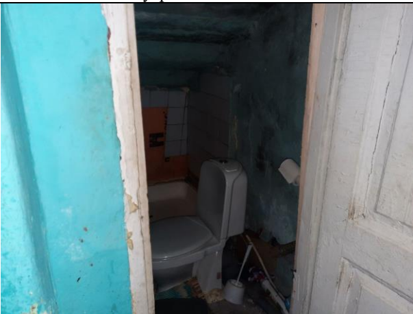
Фото № 11 – Внутреннее состояние помещения
