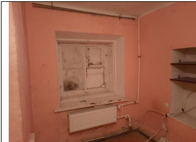
Фото № 15 – Внутреннее состояние помещения
