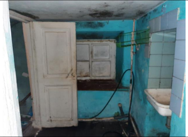
Фото № 10 – Внутреннее состояние помещения
