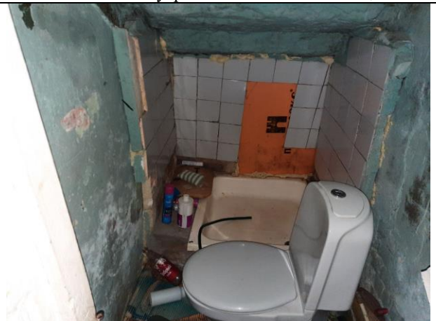
Фото № 12 – Внутреннее состояние помещения
