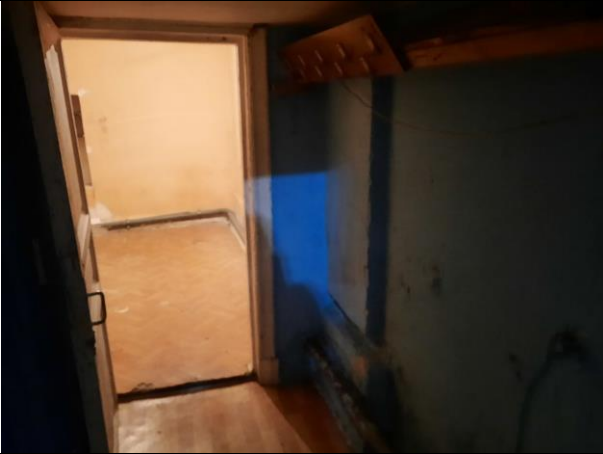
Фото № 9 – Внутреннее состояние помещения
