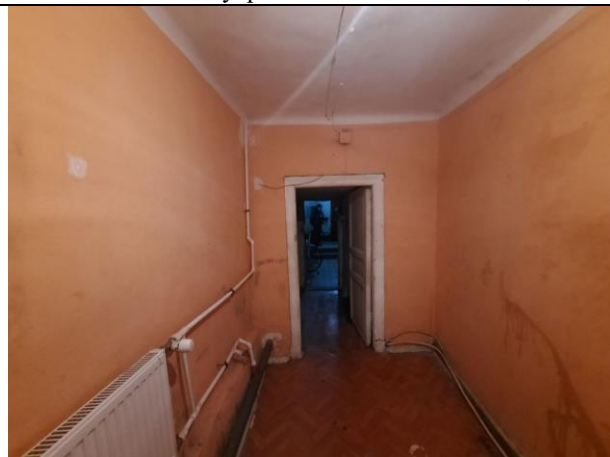
Фото № 18 – Внутреннее состояние помещения
