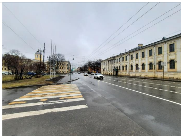
Фото № 2 – Подъездные пути
