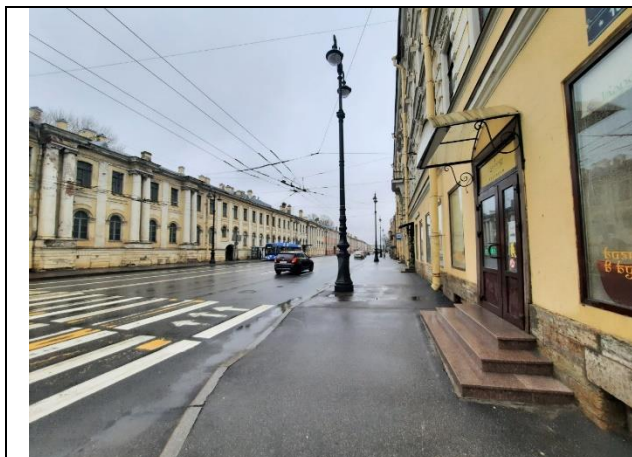
Фото № 1 – Подъездные пути
