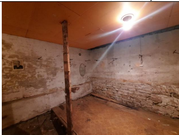
Фото № 9 – Внутреннее состояние помещения
