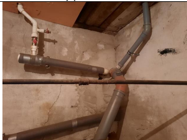
Фото № 10 – Внутреннее состояние помещения
