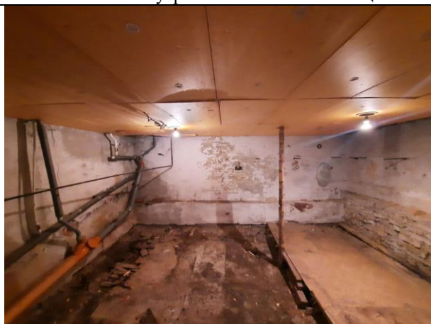
Фото № 13 – Внутреннее состояние помещения
