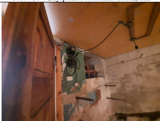
Фото № 11 – Внутреннее состояние помещения
