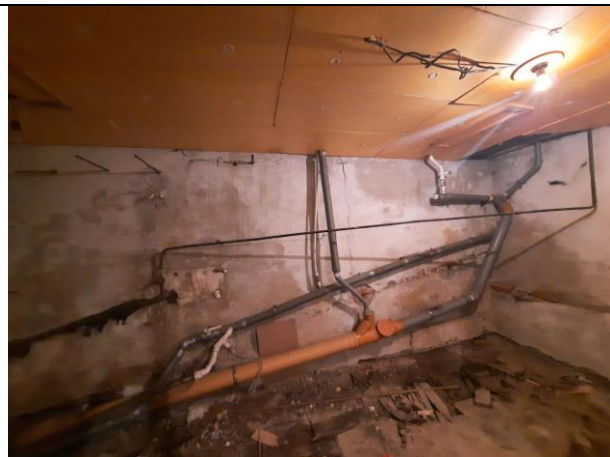
Фото № 8 – Внутреннее состояние помещения
