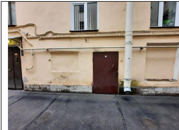
Фото № 7 – Вход в помещение со двора
