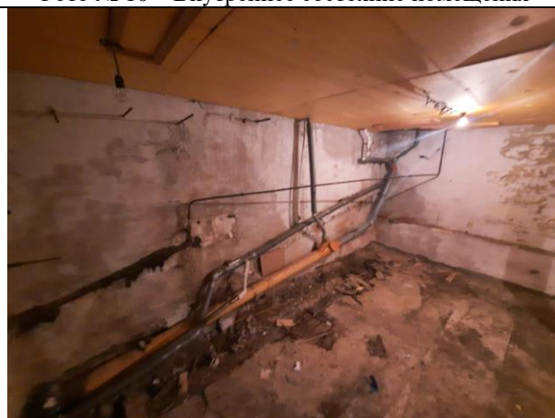
Фото № 12 – Внутреннее состояние помещения
